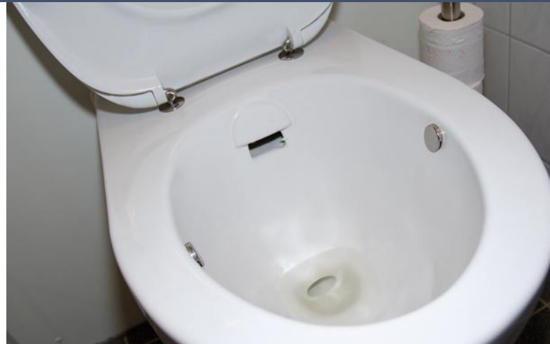
Een vacuümtoilet waarmee heel veel spoelwater wordt bespaard (gemiddeld 1 i.p.v. 8 liter).
