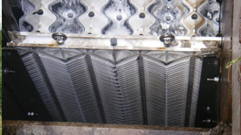
Detail van een lamellenafscheider.
