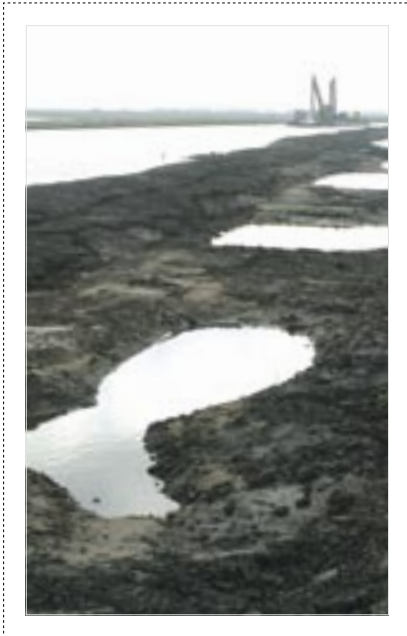
35 /AANLEG VAN EEN PAAIPLAATS
