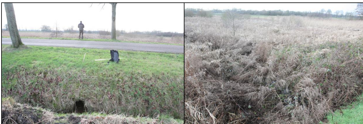
Figuur 3.4. Links: een duiker die in natte perioden nutriëntenrijk oppervlaktewater van een greppel langs de Gasterensche Weg naar het beekdal transporteert. Het water is drainagewater en water dat over maaiveld afstroomt van de Gasterensche zandrug. Rechts: het uitstroompunt van dezelfde duiker met in het beekdal een productieve vegetatie van Riet en Grote lisdodde. Het oppervlaktewater verspreidt zich in het vernatte beekdal over het maaiveld (foto's januari 2021). Figure 3.4. Left: a culvert transporting nutrient rich agricultural water from a ditch to the brook valley. Right: outlet of the culvert with a productive vegetation of reed and cattail in the brook valley. The surface water is spreading in the rewetted brook valley by runoff.
