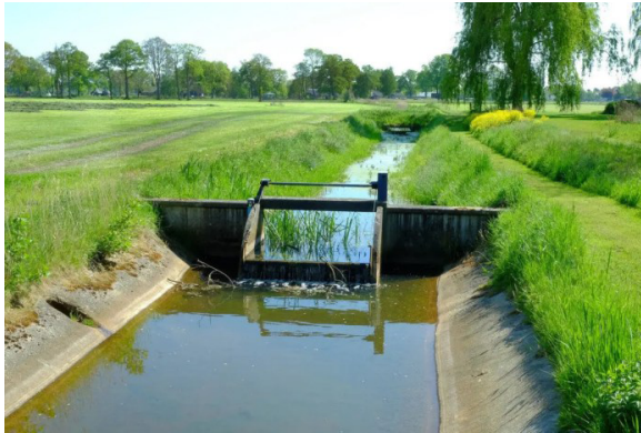
AFBEELDING 3.11 REGELBARE STUW ZONDER UITSTROOMBAK
