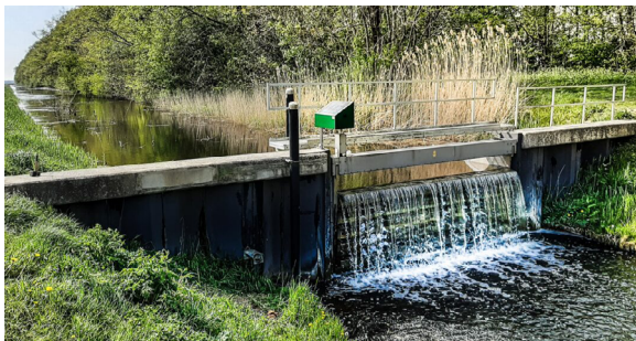
AFBEELDING 3.11 REGELBARE STUW ZONDER UITSTROOMBAK
