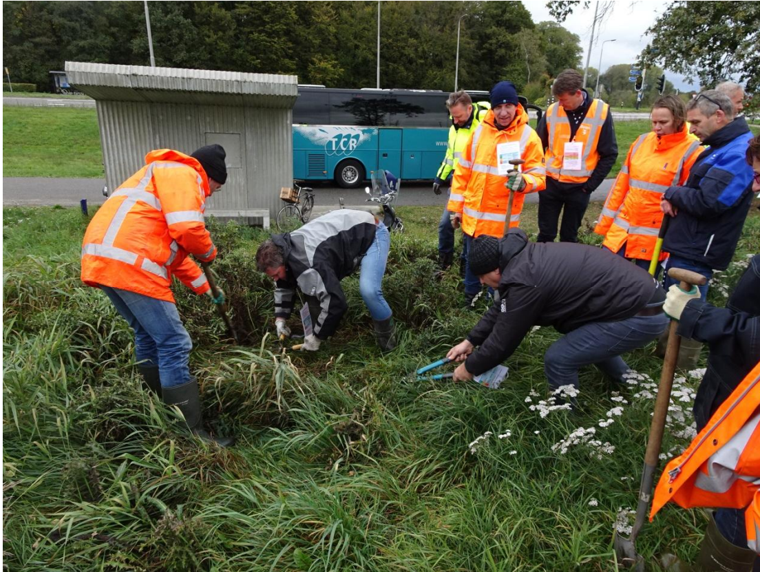
Even de dijk bij RWS Oost Nederland inspecteren.
