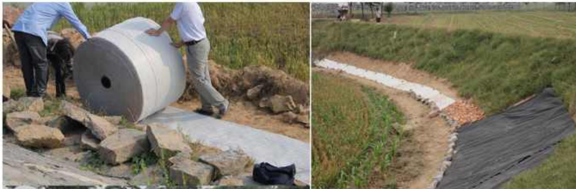
Figuur 4.5 Uitrollen van de textielrol waarin de glasvezels zijn aangebracht. (Bron: Deltares).
