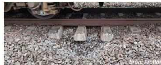
verzakking door beverhol onder spoor bron: ProRail
