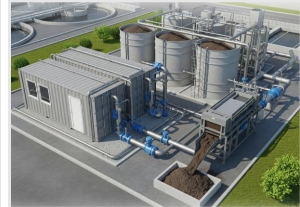
Volle-schaal proces 4000 L/h Zuivering papierfabriek Eerbeek
