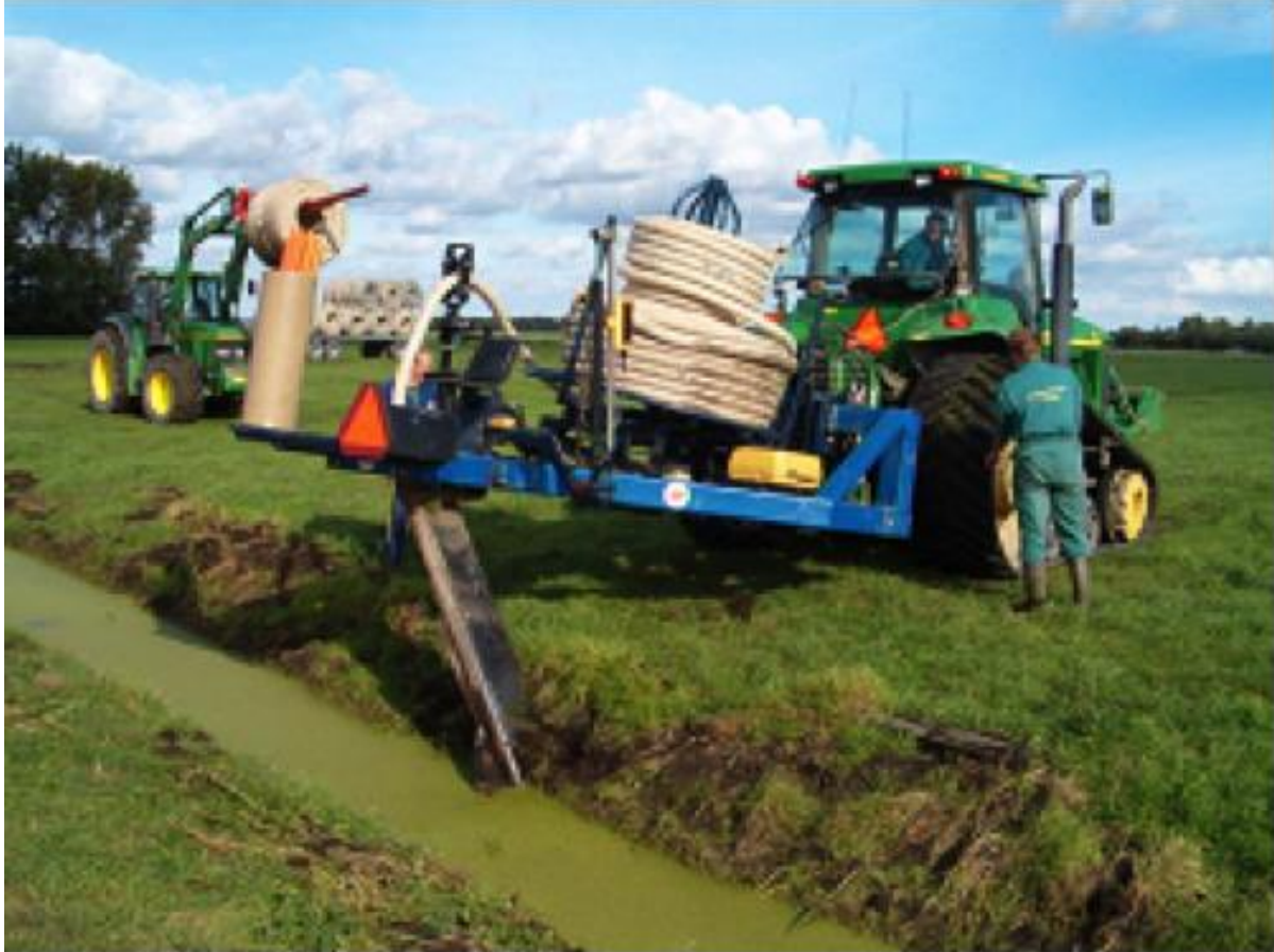
De drains worden onder het slootpeil aangebracht
