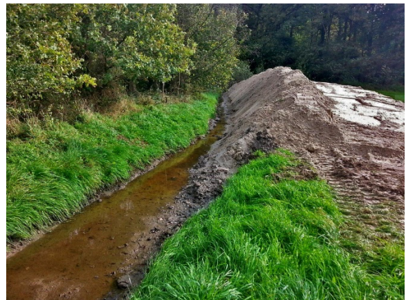
Zandsuppletie in de Snoeyinksbeek (Foto: Ecogroen)
