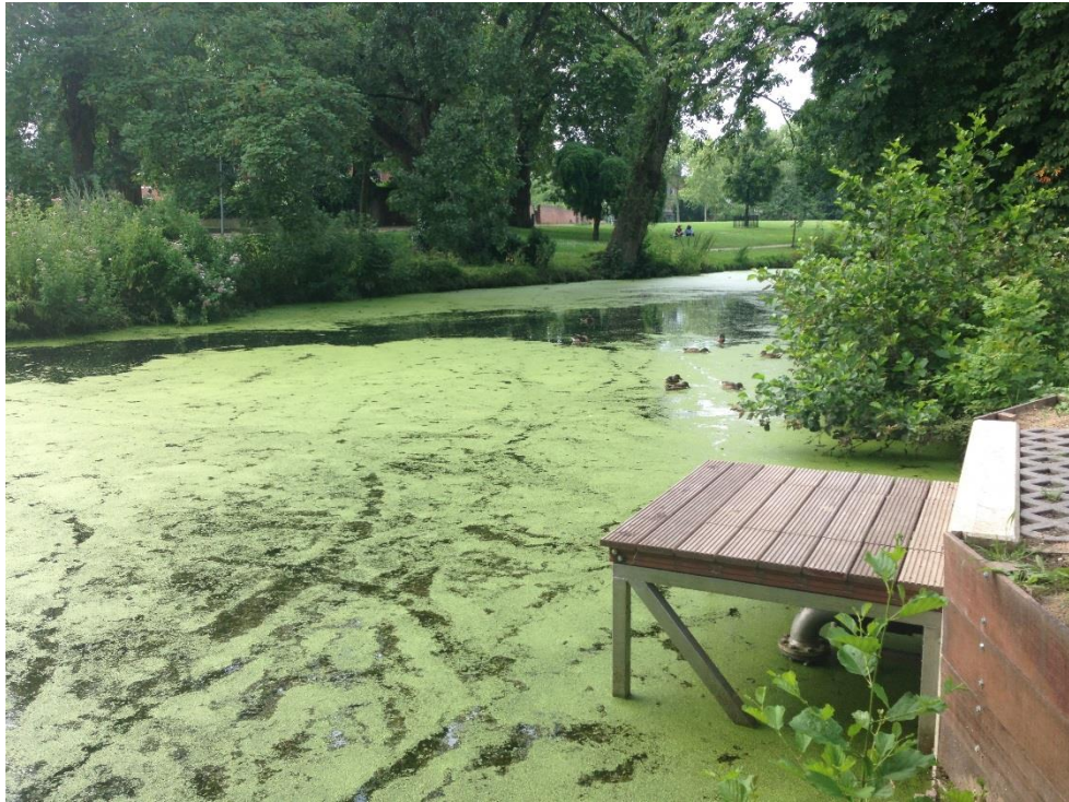
Figuur 7.3 | Inlaat van een TEO systeem. De inlaat is boven water geplaatst onder een steiger.
