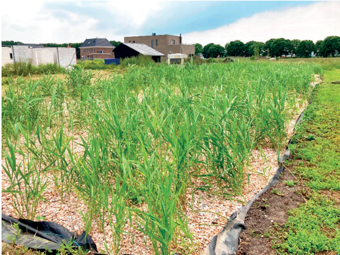
Afbeelding 1 Helofytenfilter in Oosterwold
