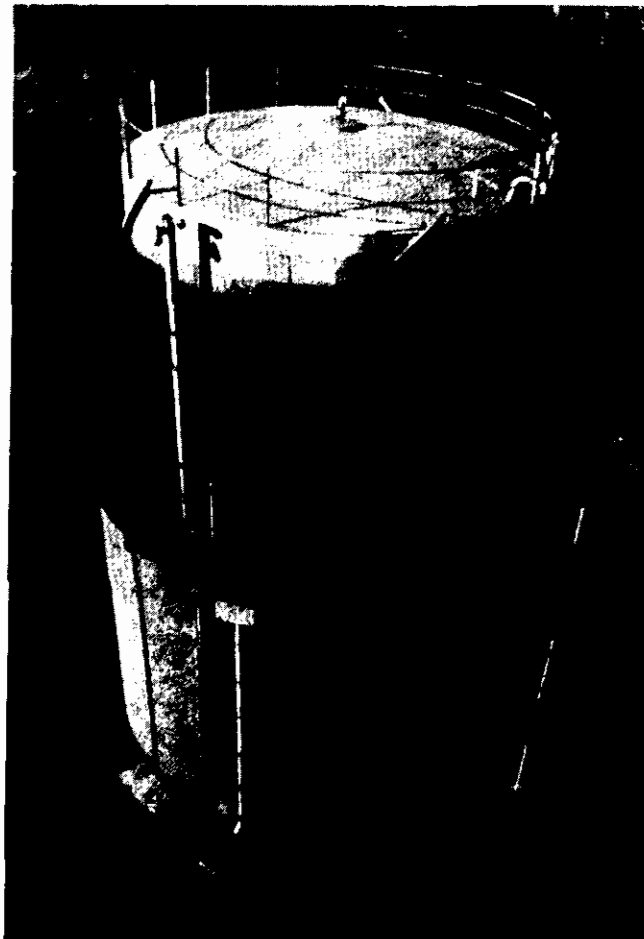
Fig. 45. Drijvend dak gashouder in volledig gevulde toestand.
