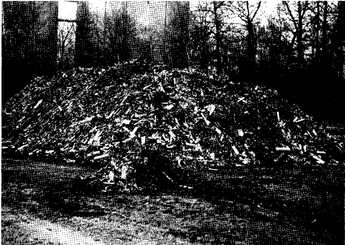
Figuur 6. Stapeling van slib gemengd met vochtregulerend - en porositeitverhogend toeslagmateriaal.
