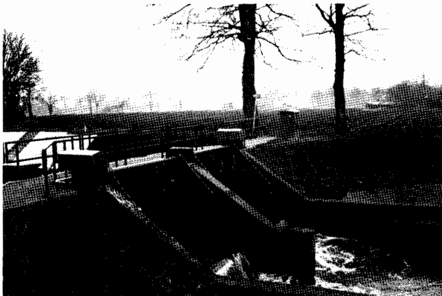
Waterschap Salland: automatisch geregelde stuw
