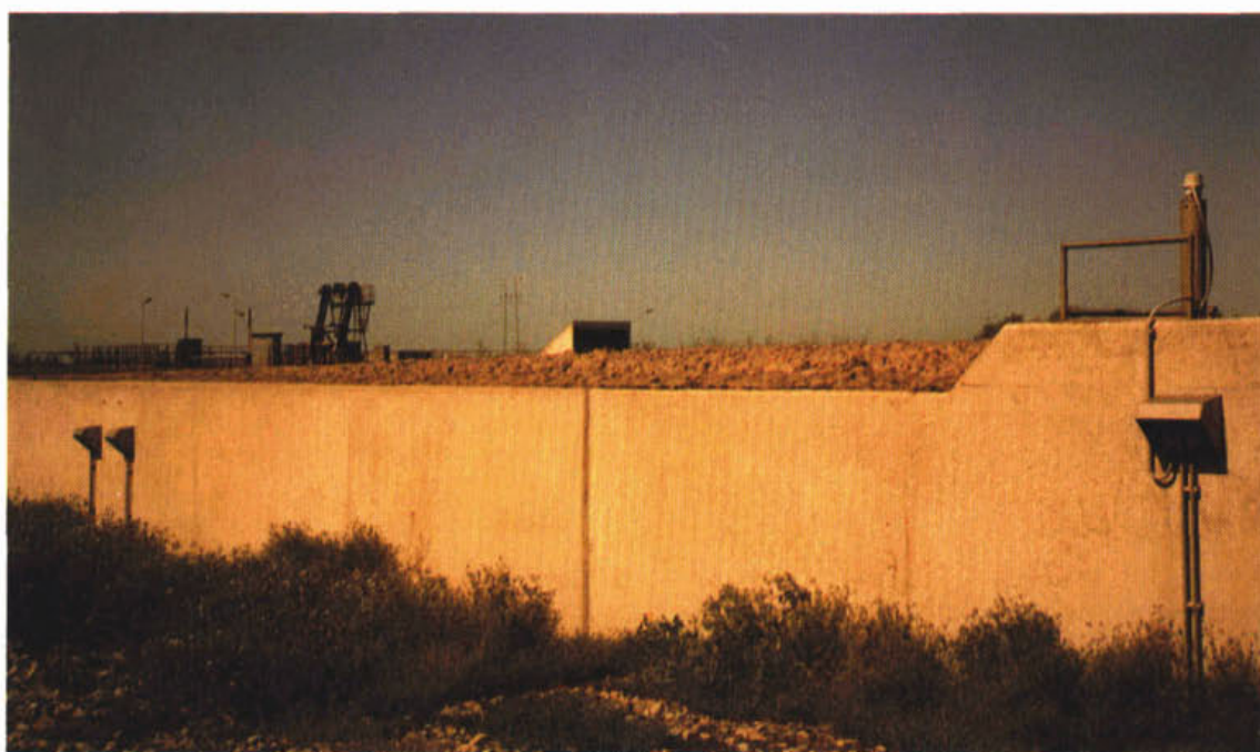
Figuur 4 Zijaanzicht van een aëratietank. De drijfslag komt boven de wand uit.
