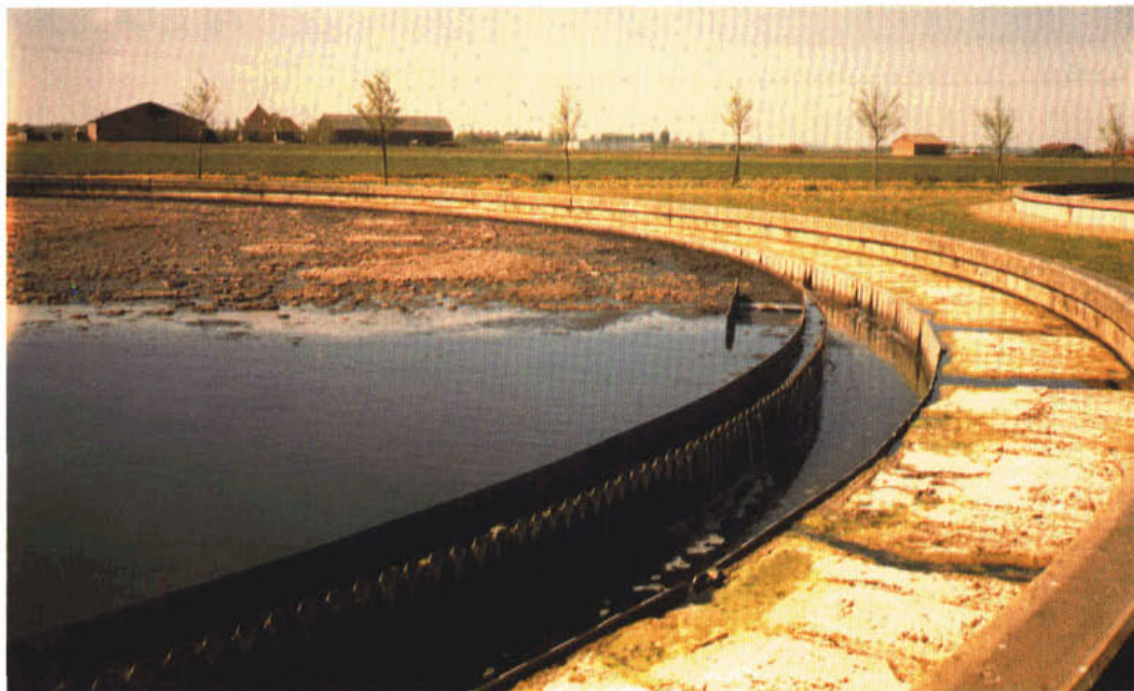
Figuur 3 Een ten dele verlande drijfslag op een nabezinktank.
