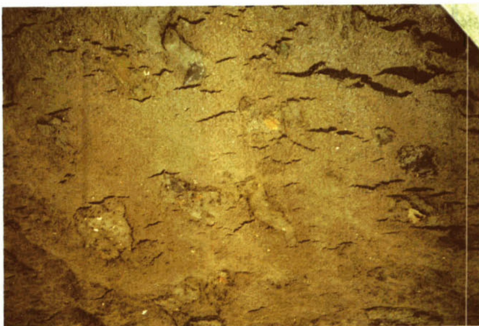
Figuur 8 Een oude, bijna verlandende drijfslag op de beluchtingsruimte.
