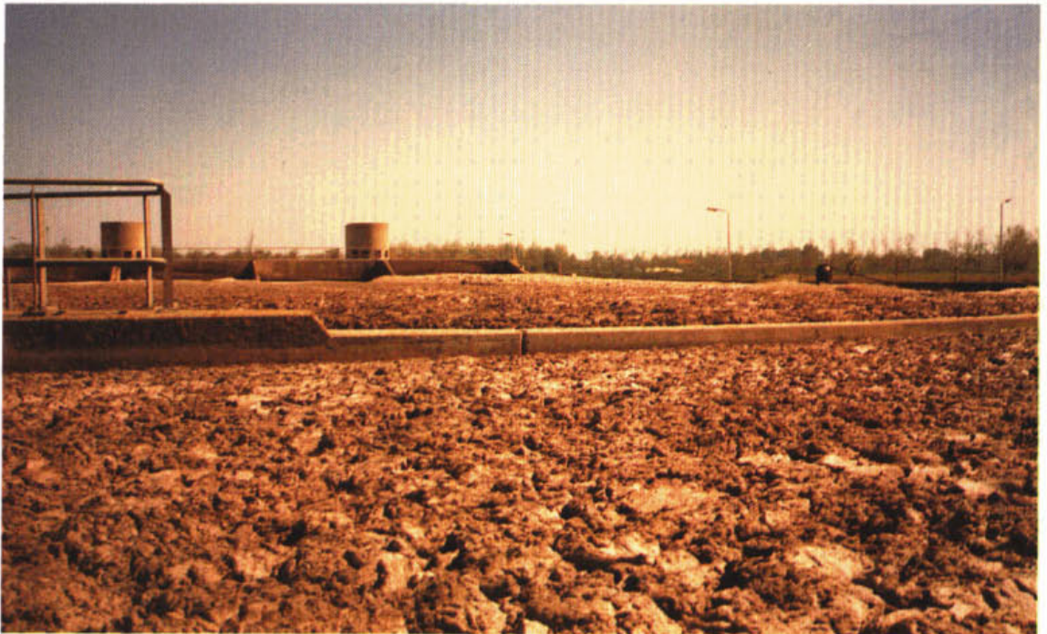
Figuur 2 Het oppervlak van de beluchtingsruimte is volledig bedekt door een drijfslag.
