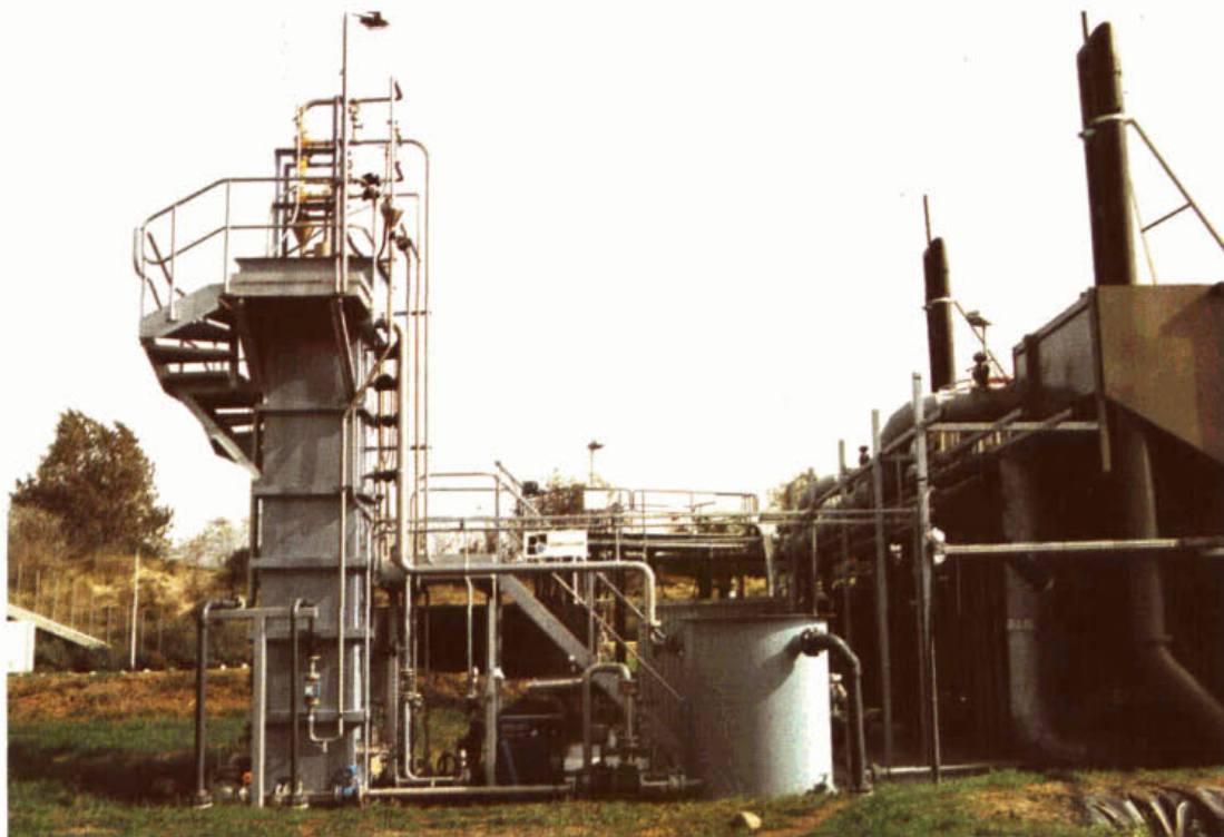
Figuur 5 Het denitrificerend fluidbedsysteem van Dorr-Oliver (anoxische Oxitransysteem)
