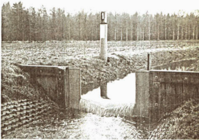
Figuur 8a Analoge recorder op peilbuis bij Rossum-stuw
