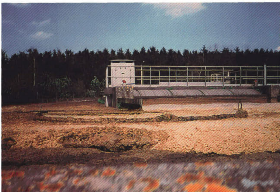
Figuur 21: Bij een overbelaste RWZI biedt een selector geen uitkomst
