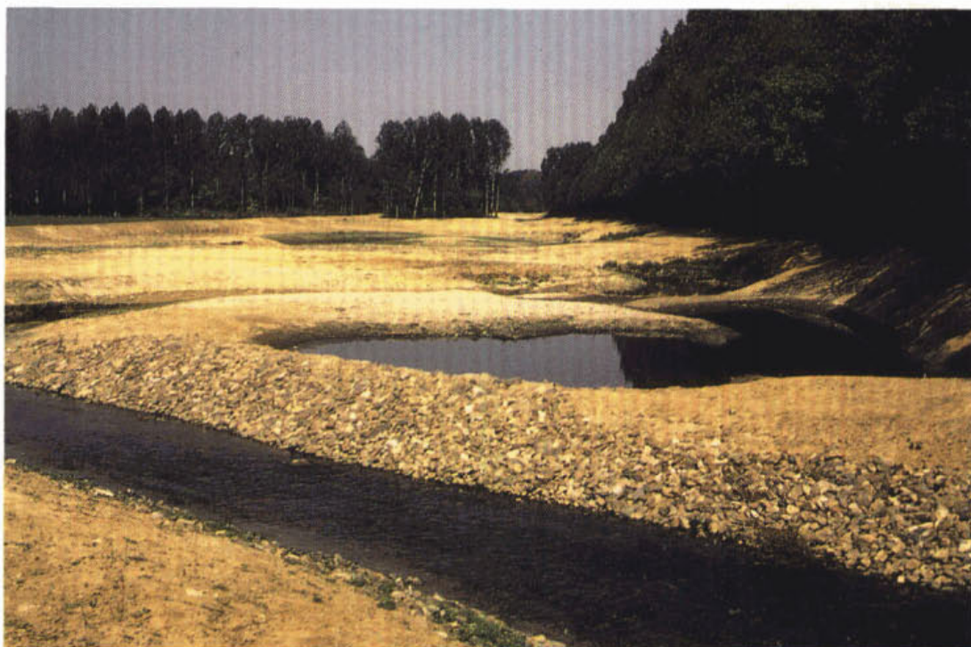
Vloedgraaf; gegraven meandering en aanleg poelen
