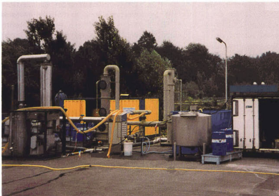
Figuur 7 Overzicht van de proefinstallatie met luchtstrippen op de rwzi Utrecht
