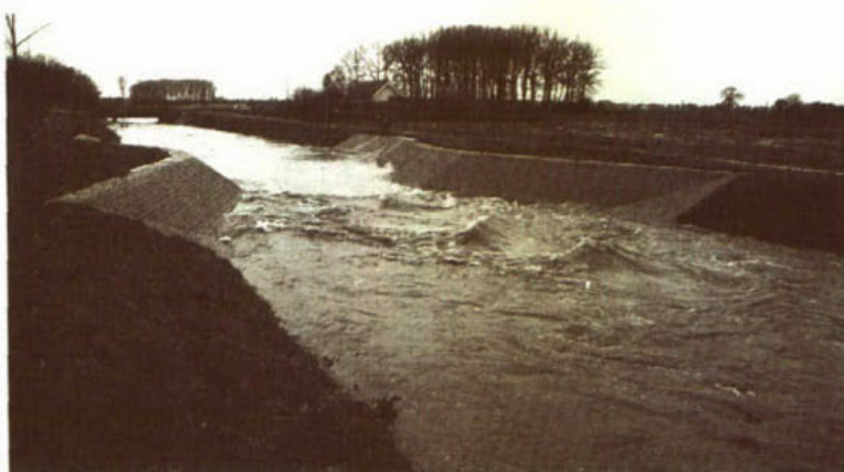
Afbeelding 3. Meetgoot in de Geleenbeek.
