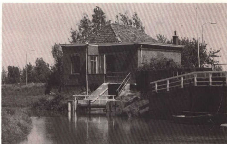
Afbeelding 1. Gemaal van de Dijkpolder te Maasland.
