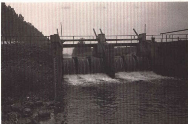
Afbeelding 5. Automatische klepstuw in de Soestwetering (afwateringsgebied 10.000 ha).
