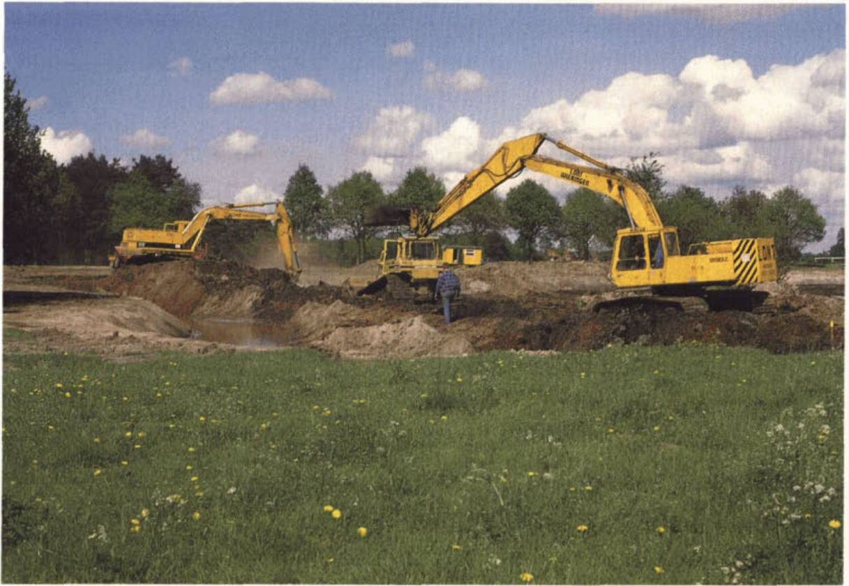
Uitvoering van graafwerkzaamheden
