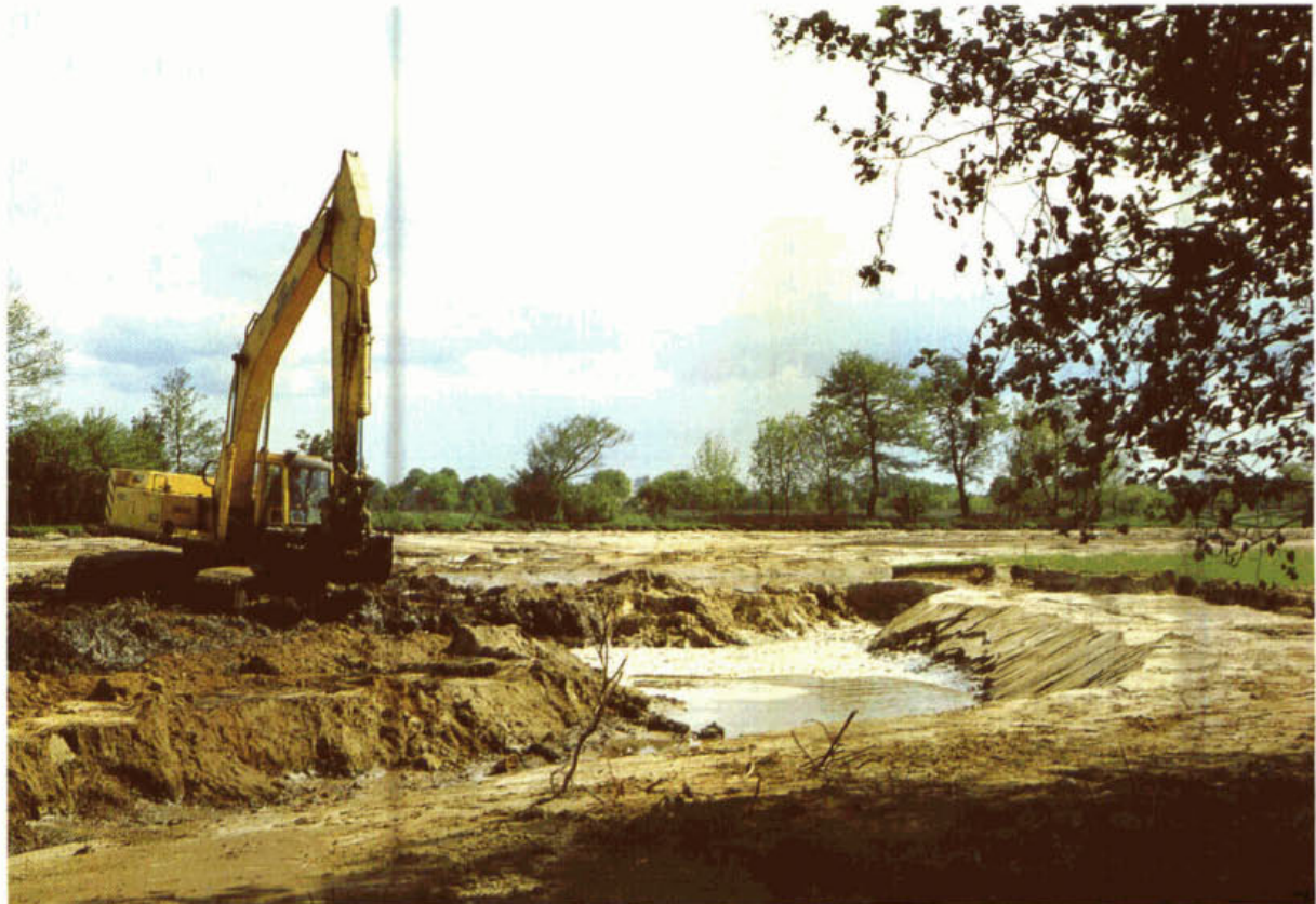
Vergunningen zijn nodig voor de uitvoering van graafwerkzaamheden
