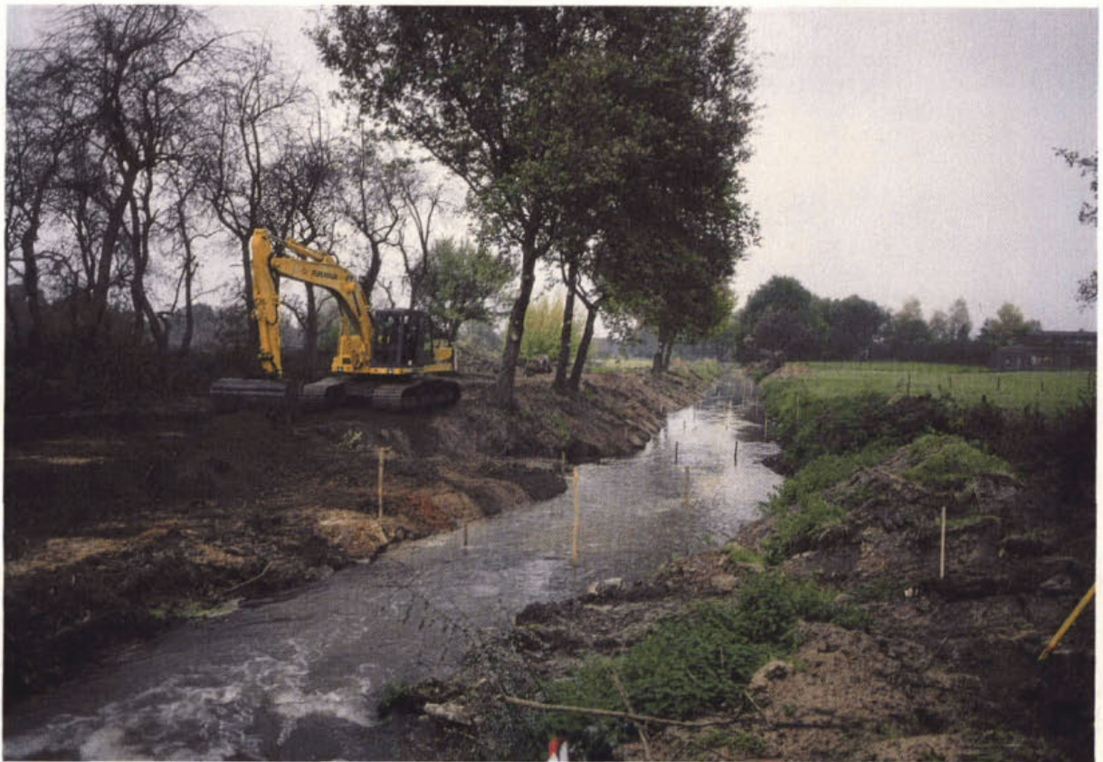
Aanleg tweefasen bedding
