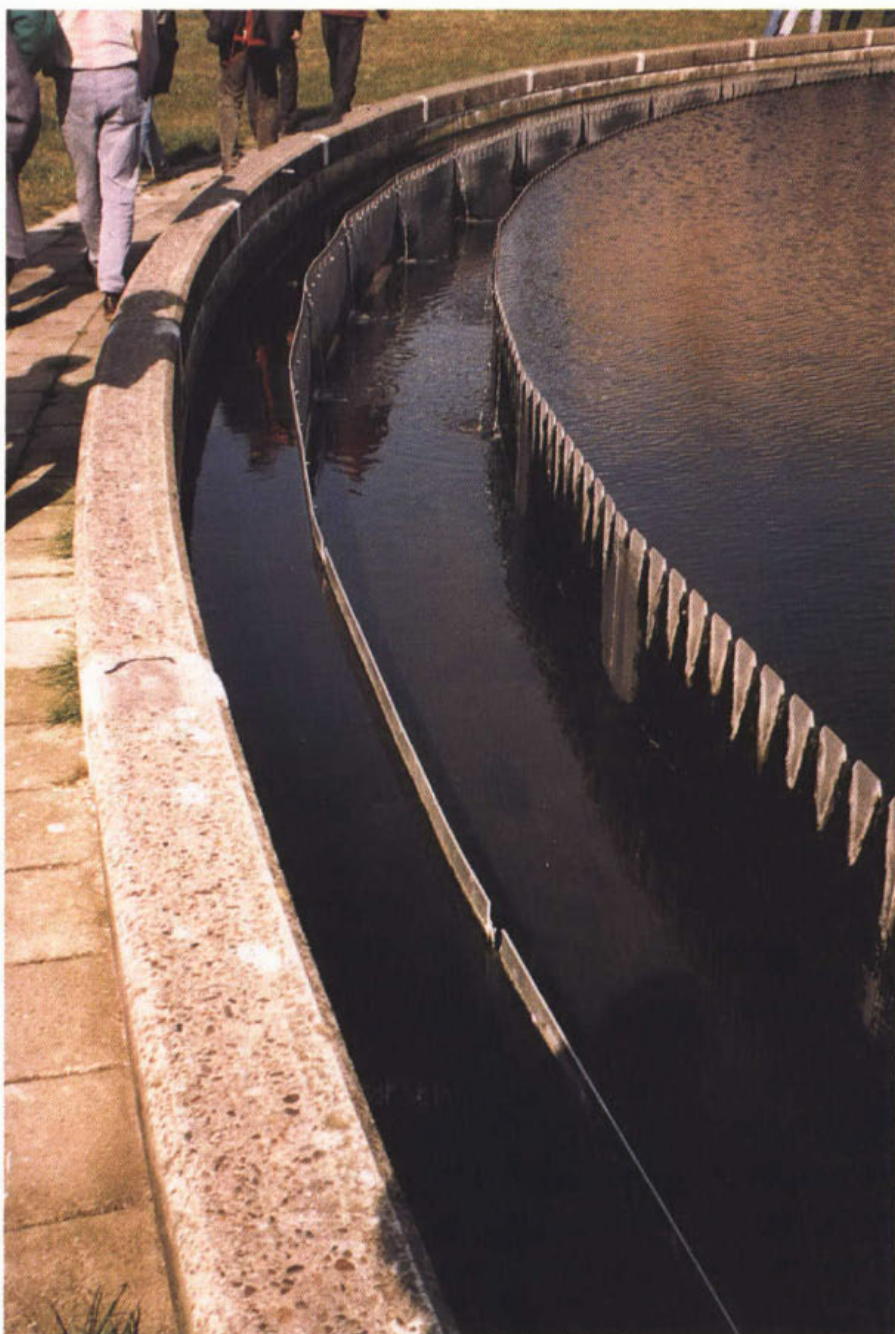
De overstortranden van de nabezinktank van de rwzi Veenendaal. Onderzoek aan het functioneren van deze tanks en ten behoeve van ontwerp staat beschreven in de STOWA-rapporten 81-11, 83-3, 93-18 en 93-19.
