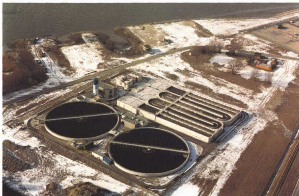
rwzi Hoogvliet; capaciteit 75.000 i.e. compacte bouw met biologische fosfaat- en stikstofverwijdering. [Foto: Aeroview]
