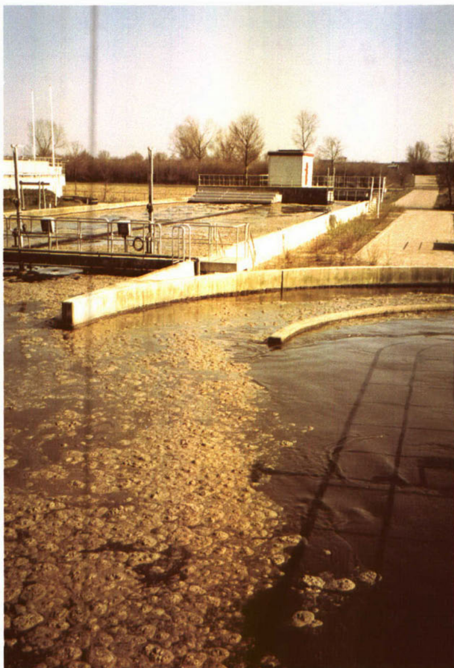
De rwzi Veenendaal, omgebouwd naar een Carrousel 2000 door het toevoegen van een anaërobe contactruimte ("oor" aan de carroussel). Processen o.a. beschreven in STOWA-rapporten 94-11 en 94-16.
