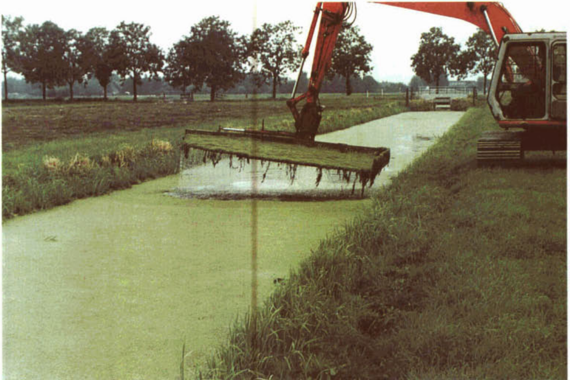
Foto 3.1 Apparaat om kroos te verwijderen van Loonbedrijf Firma Blokland uit Stolwijk [Corporaal en van Houwelingen, 1996]
