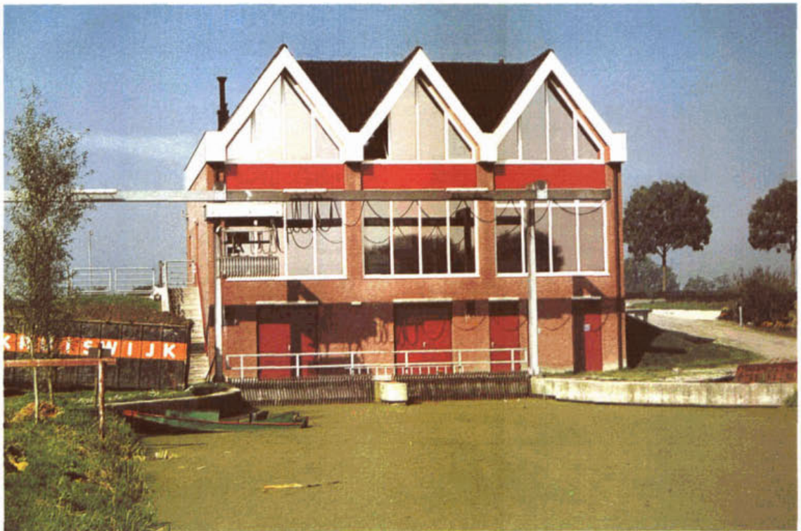
Foto 1.4 Opstuwing van kroos bij een gemaal
