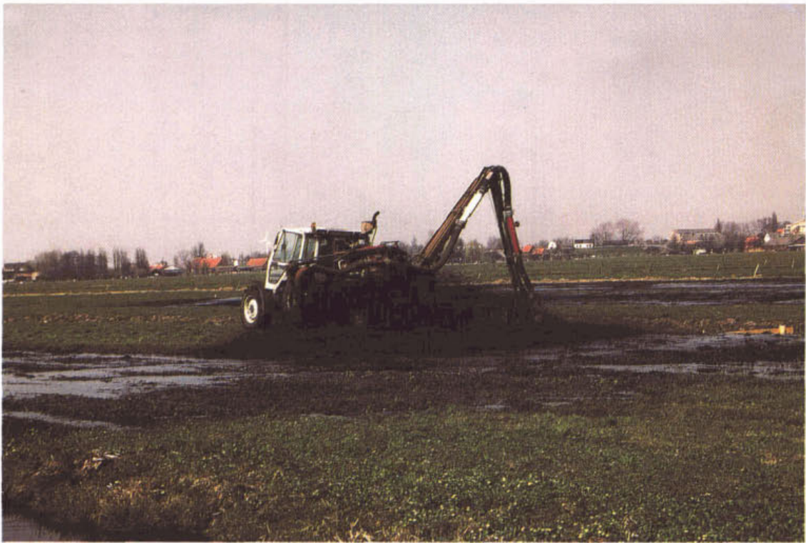
Foto 2.1 en 2.2 Baggeren van traject en verspreiden van bagger over het land
