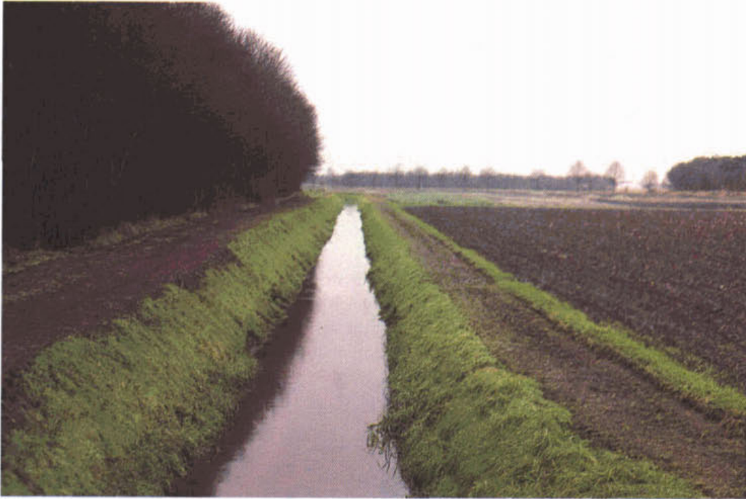
Foto 5: Onderhoudspaden aan weerszijden van de waterloop
