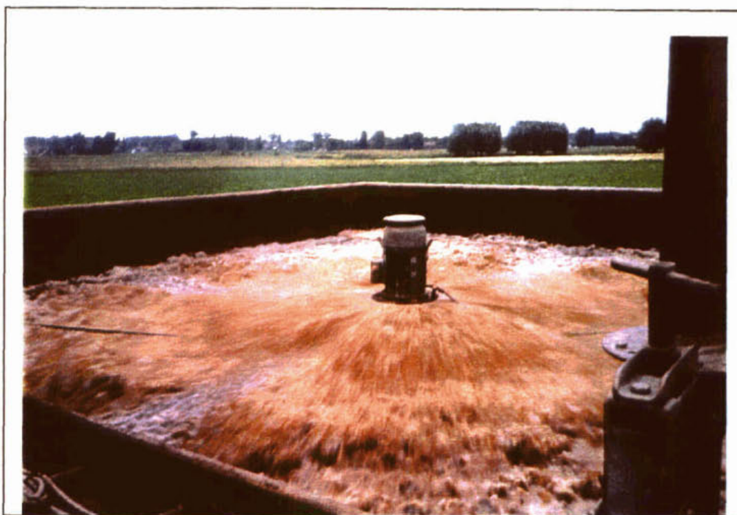
Figuur 6. Principeschema van een sneldraaiende puntbeluchter
