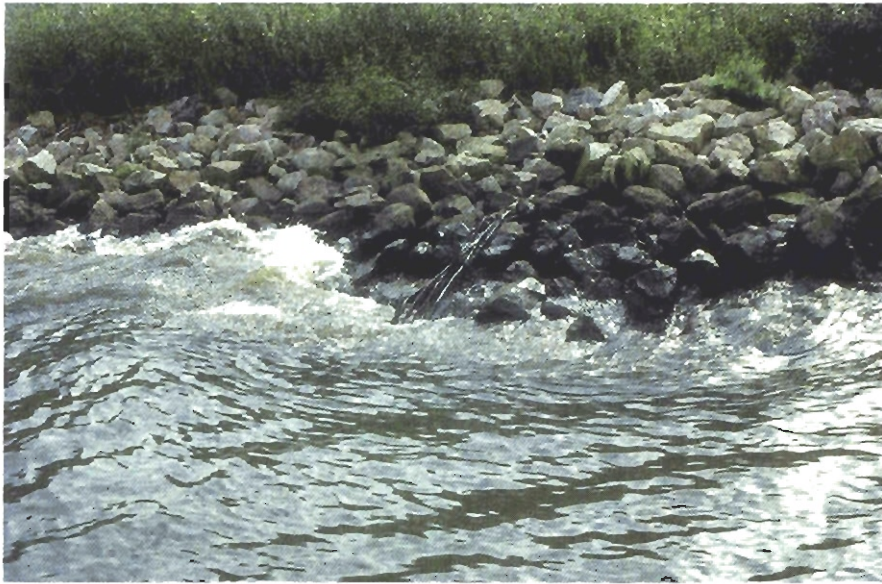
Abbeelding 2.3 Een door golven belaste taludverdediging langs de Amer. (Foto M. de la Haye)
