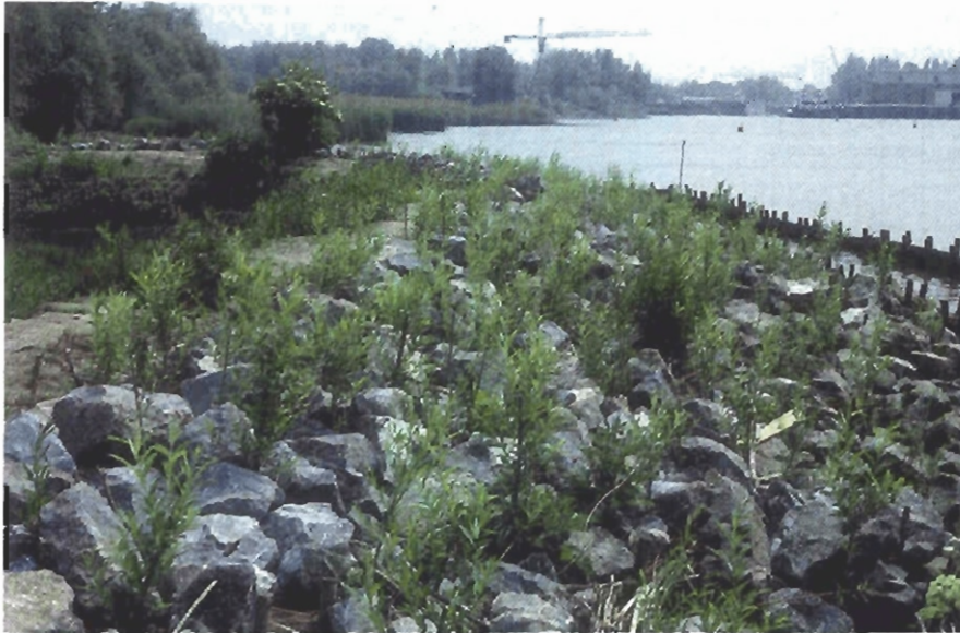
Abbeelding 2.6 Doorgroeiconstructie langs de Nieuwe Maas nabij Sormpolder. (Foto J.L. Koolen)
