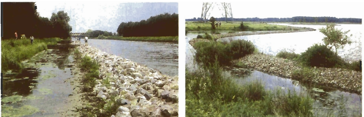
Afbeelding 2.5 Breukstenen vooroeververdediging langs het kanaal Wessem Nederweert (links) en langs een grindgat bij Maasbracht (rechts). (Foto's J.L. Koolen)
