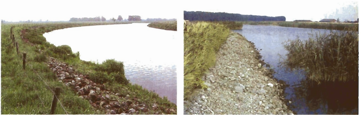
Afbeelding 2.4 Taludverdediging langs de Overijsselsche Vecht (links) en langs de Vliet bij Boompjesdijk (rechts). (Foto's J.L. Koolen)
