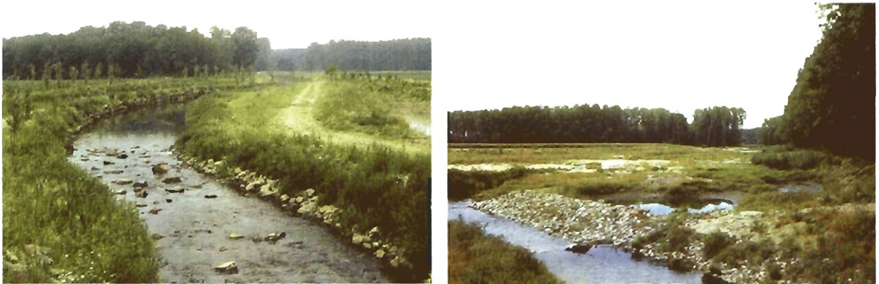
Afbeelding 2.2 Toepassing van breuksteen langs een traject van de Vloedgraaf waar beperkt ruimte was voor hermeandering (links). Rechts een traject waar veel ruimte was voor hermeandering en waar op enkele plaatsen breuksteen is toegepast om het proces van hermeandering iets te sturen. (Foto's J.L. Koolen en J. Simons)
