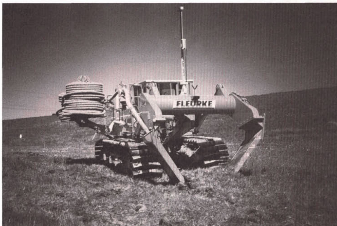
Figuur 3.1 Aanleg drainage middels sleufloze techniek.
