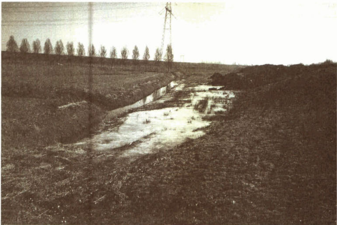
Figuur 5.1 Ijslenzen als indicator voor slecht functioneren van drainage.
