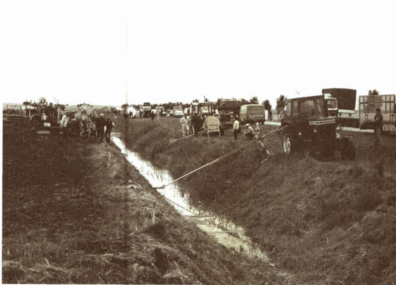
Figuur 6.1 Doorspuiten in de praktijk.
