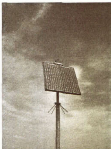
figuur 2.3. Een eenvoudige maatregel als het aanbrengen van anti-inklempennen verkleint de kans op vandalisme en diefstal.
