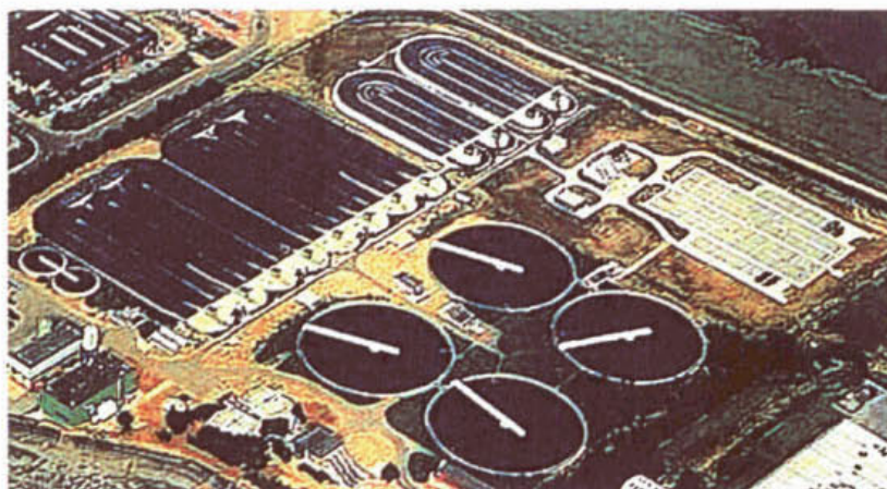
Afbeelding 53 Bovenaanzicht van de selector, de anaërobe tank en de beluchtingscircuits, rwzi Venlo
