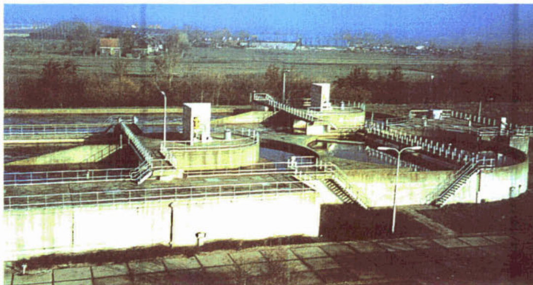
Afbeelding 29 Bovenaanzicht van selector, voordennitrificatietank en een deel van het belichtingscircuit, rwzi Katwoude
