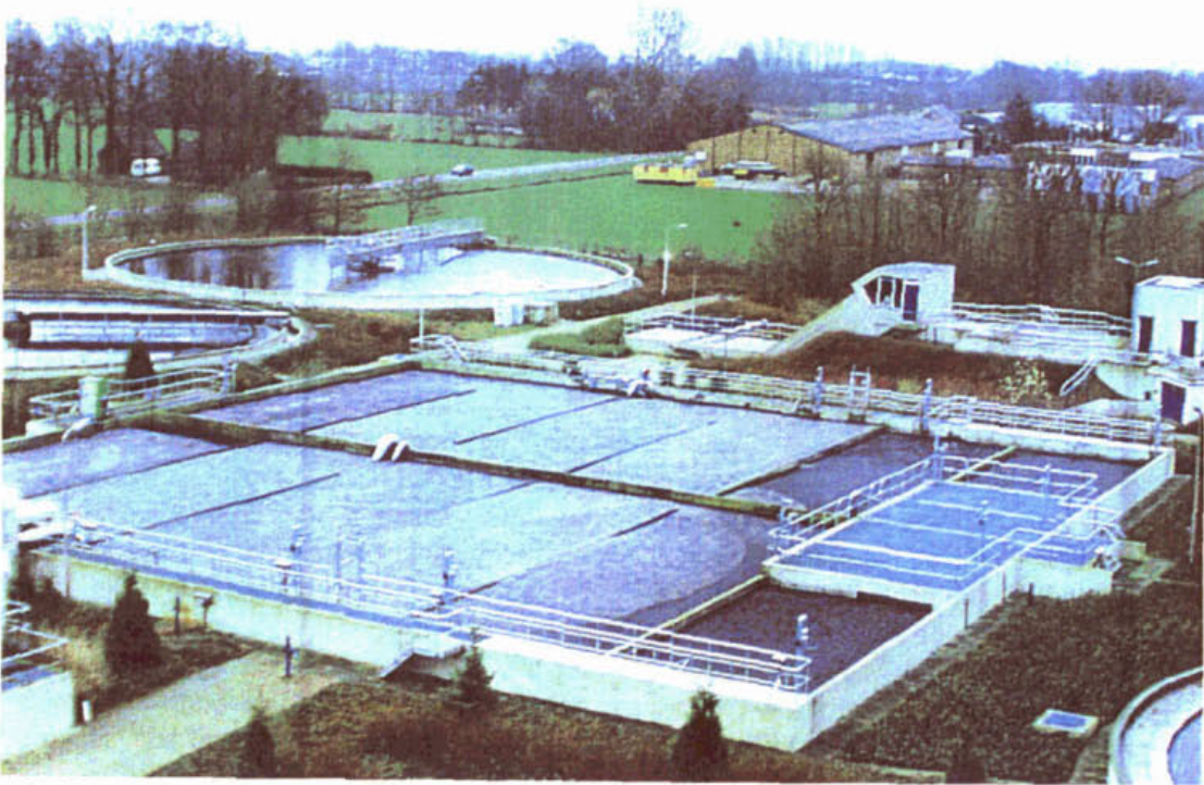
Afbeelding 33 Bovenaanzicht actiefslibtank, rwzi Goor
