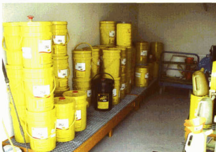
foto 2 Vaten met gevaarlijke vloeistoffen op lekbak
