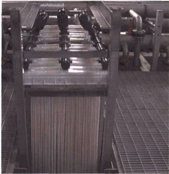
Foto boven: Zenon MBR-module. Midden: effluent MBR. Onder: vergelijking effluent rwzi Beverwijk en MBR-installatie.
