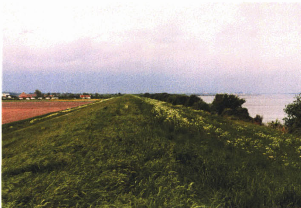
Figuur 5.4 Overzicht van de dijk
