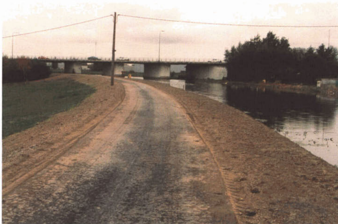
Figuur: Opgehoogde boezemkade langs de ringvaart van de Zuidplaspolder
