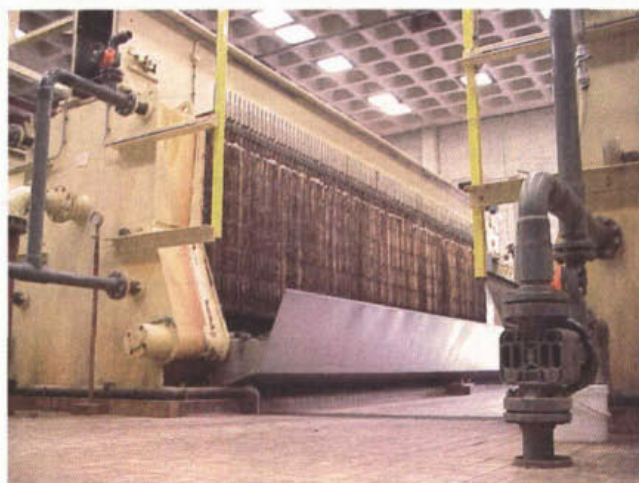
Afbeelding 7 Foto van de kamerfilterpersen van het slibbedrijf van de rwzi Garmerwolde
