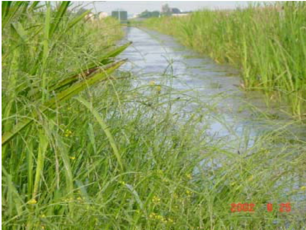
DE PROEFSLOOT IN DE VLIETPOLDER IN DE ZOMER VAN 2002.
