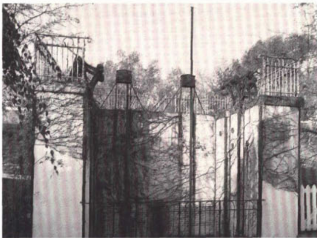
331. Dubbele duikersluis bij het voormalige gemaal bij Spijk.
