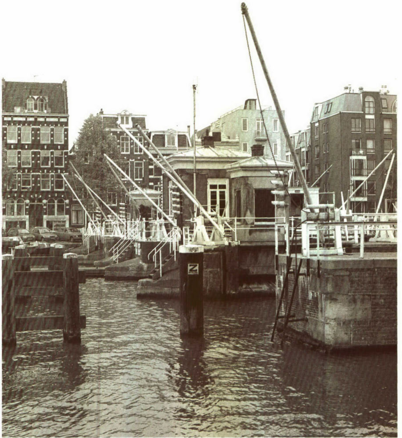
De Amstelsluizen in de Amstel te Amsterdam, zie pag. 26 en 169. (Fotografische Dienst Bouwkunde, TU Delft).
