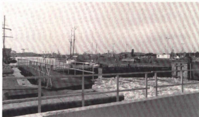
117. De keersluis te Vlissingen met schipdeur (op de voorgrond) en eb- enloeddeuren.
