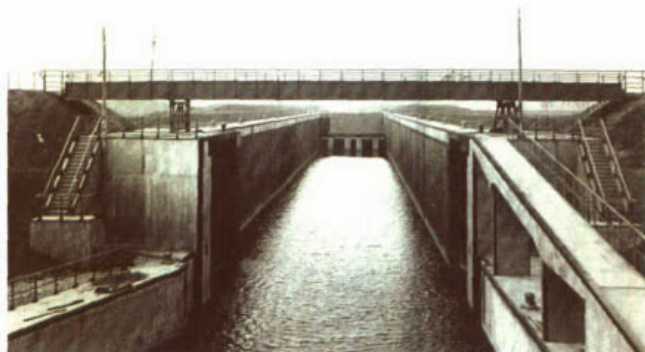
128. De schutsluis te Maasbracht tijdens de bouw rond 1928; op de achtergrond het bovensluishoofd waarin de klepdeur moet worden geplaatst.
