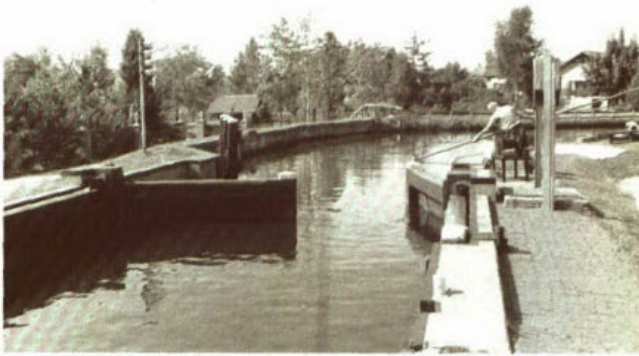
171. Het openen van de sluisdeur met behulp van een bootshaak bij de schutsluis te Woerdense Verlaat; op de voorhar is daartoe een haalpen aangebracht.
