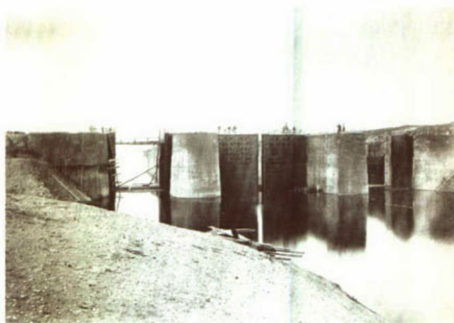
422. Dubbele schutsluis te IJmuiden tijdens de bouw in 1872 met geheel rechts de uitwateringsluis.
