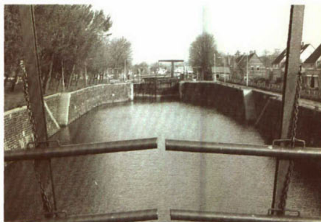
417. De Koninginnesluis te Vreeswijk (Nieuwegein): de gekoppelde sluis gezien vanaf het buitensluishoofd.
