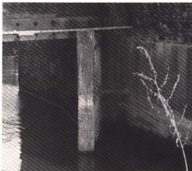
185. Wachtdeur met stalen kruk in een uitwateringssluis bij Brakel.
