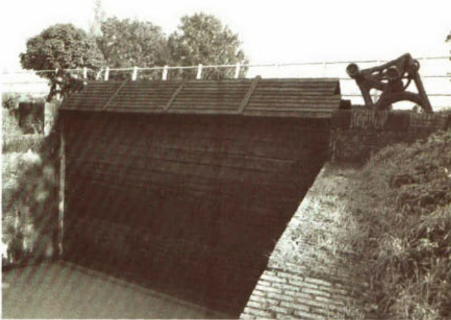
364. Schotbalken in de inundatiesluis in de Zuider Lingedijk bij Asperen.
