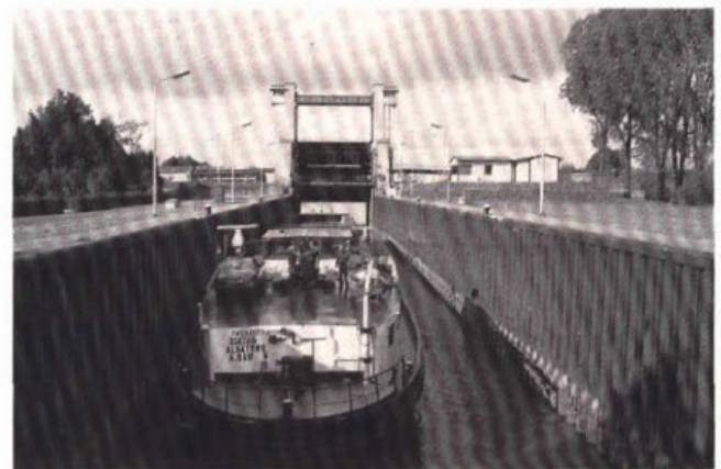
131. De schutsluis met hefdeuren bij St. Andries in de verbinding tussen de Waal en de Maas.
