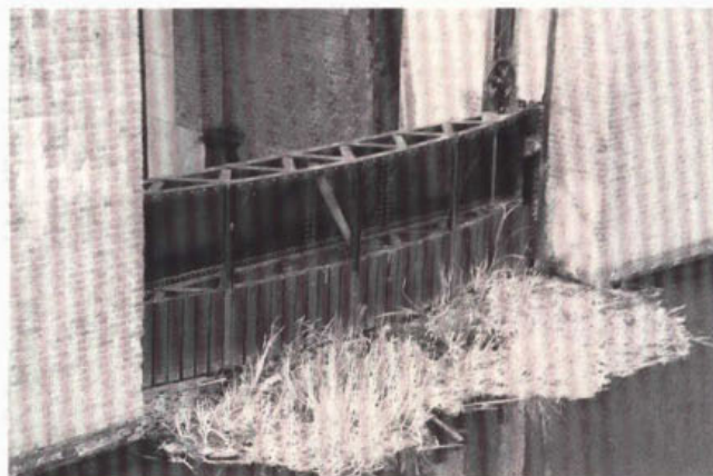
310. Constructie van de grote Stoney-schuif in het Afwateringskanaal bij Waalwijk, waarvan de half gebogen hoofdregels zijn uitgevoerd als vakwerkconstructie.
