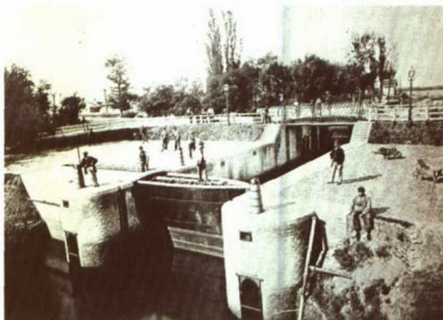
85. Roldeur in de Cellesluis te Kampen uit 1868.
