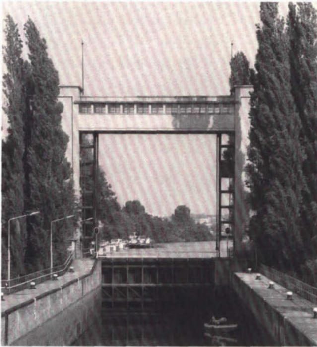
293. Schutsluis met hefdeur in het Bosscheveld te Maas-tricht.
