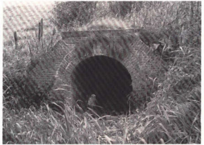
361. Uitwaterings-inundatiesluis in de Buitendijk bij Oud-Drimmelen uit 1663.
