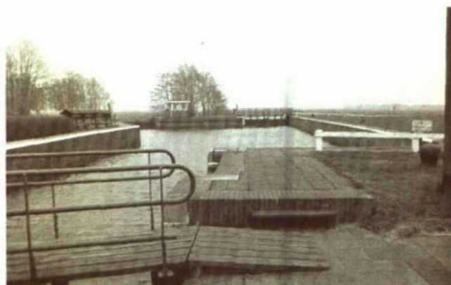
110. De Driewegsluis in de Linde ter plaatse van de kruising met de Helomavaart.
