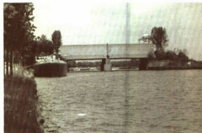
139. De plofsluis in het Amsterdam-Rijnkanaal bij de splitsing met het Lekkanaal.
