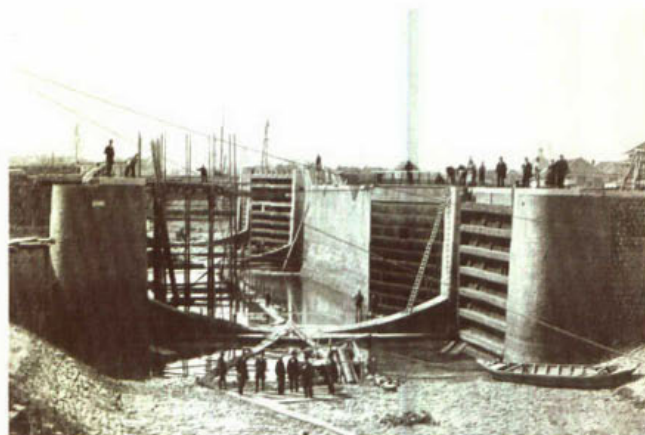
398. Willem III-sluis te Amsterdam met houten en ijzeren puntdeuren tijdens de bouw in 1865.
