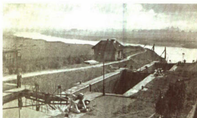
399. Drietrapsluis in het Apeldoornsch Kanaal bij Dieren uit 1869.
