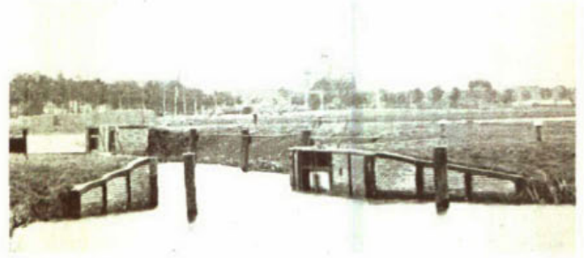
448. Baksteen troggewelfjes tussen ijzeren stijlen in de schutsluis in de Trageldijk bij Coevorden.
