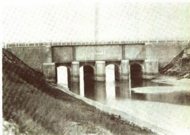
347. De Wachtsluis bij Vlissingen vlak na de bouw in 1871.
