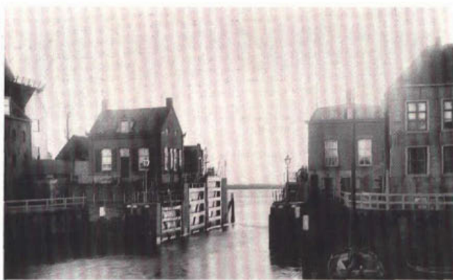
413. Het buitensluishoofd van het Benedensas in de uitmonding van de Steenbergsche Vliet bij Steenberg.
