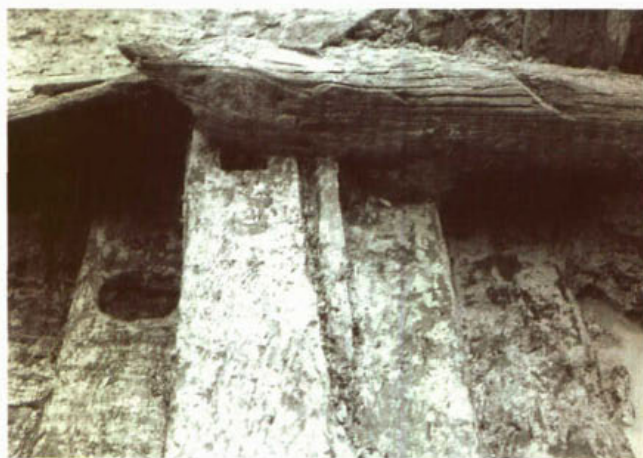
147. Aanslagdrempel en taatskom (links) van de in 1991 gegraven 13de-eeuwse sluis te Rotterdam.
