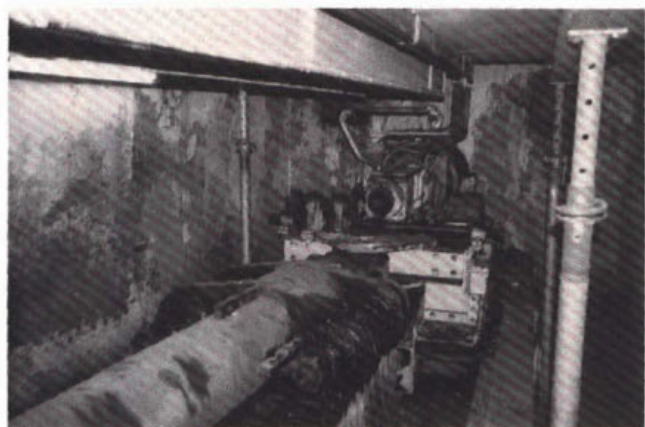
184. Tractor als bewegingswerk voor de middensluis te IJmuiden; op de voorgrond links de duwpers naar de sluisdeur.
