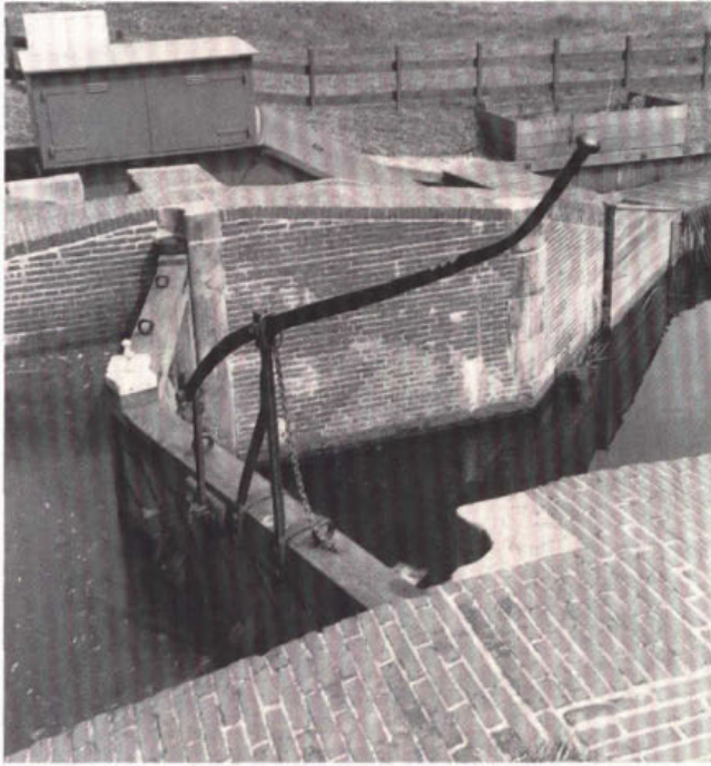
462. Rinket met hefboom in de Zuidersluis in de 's-Gravelandsche Vaart bij 's-Graveland.
