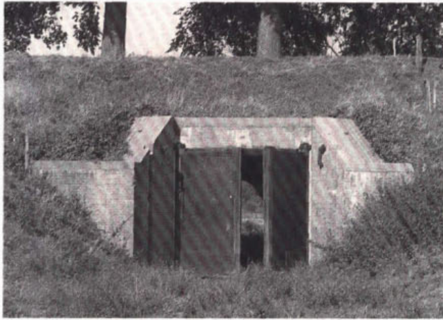
337. Duikersluis van gewapend beton langs de Maas bij Nederhemert.
