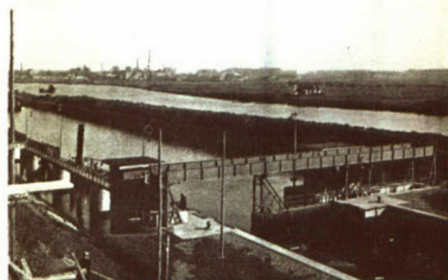
274. Drijfdeur in de schutsluis te Sint Pieter bij Maastricht.
