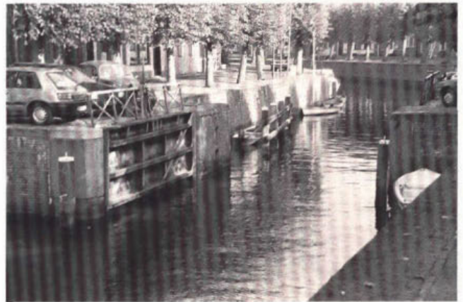
101. Enkele draaideuren van ijzer in de Dedemsvaart te Hasselt.
