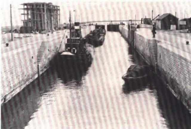
134. De schutsluis in de Afsluitdijk bij Den Oever omstreeks 1932.
