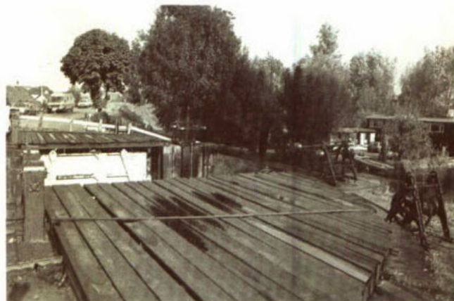
64. Inundatiesluis in de Zuider Lingedijk bij Asperen; de ijzeren deuren zijn van latere datum (1924).
