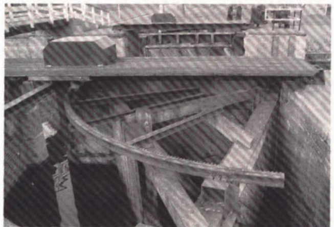
226. Houten waaierdeur met bewegingsmechanisme in het Benedensas bij Steenberg.
