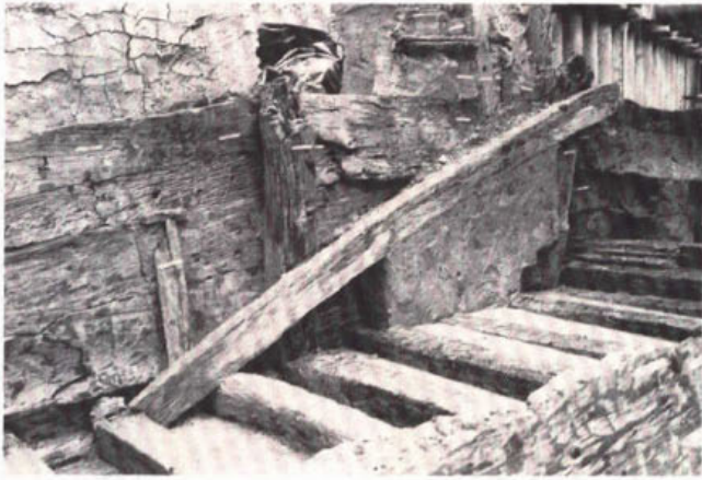
371. Schoorbalk in de in 1991 opgegraven uitwateringsluis te Rotterdam.
