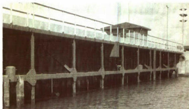
318. De schipdeur in de keersluis te Vlissingen.
