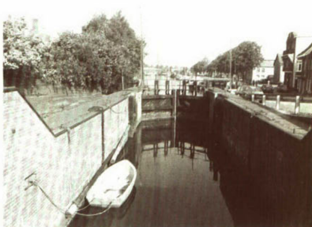
53. De Staphorster keer-schutsluis te Zwartsluis.
