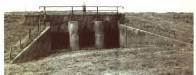
341. Inlaatsluis bij Angeren.
