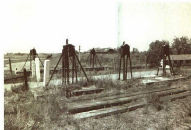
299. Windwerken voor schuiven in de inundatiesluis bij Hedikhuizen.
