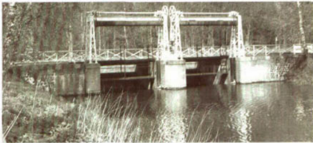
103. Stuw met Stoney-schuiven in de Dinkel bij de kruising met het Kanaal Almelo-Nordhorn.
