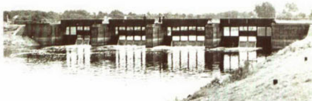
105. Stuw met schuiven in de Overijsselse Vecht bij Vilsteren.
