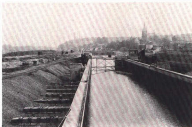
124. De schutsluis te Sint Pieter bij Maastricht in het Kanaal van Luik naar Maastricht tijdens de bouw in circa 1928.
