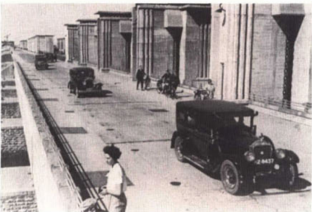
135. De uitwateringsluizen in de Afsluitdijk bij Den Oever.
