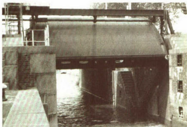
258. Segmentdeur in de Kleine Parksluis te Rotterdam.
