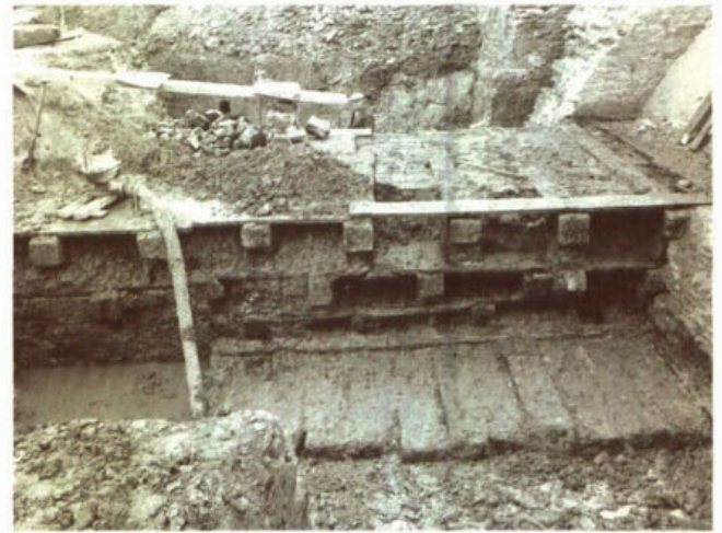
370. Drie opeenvolgende boven elkaar geplaatste vloeren in de Bergsche of Donkere Sluis te Rotterdam tijdens de opgraving in 1943.
