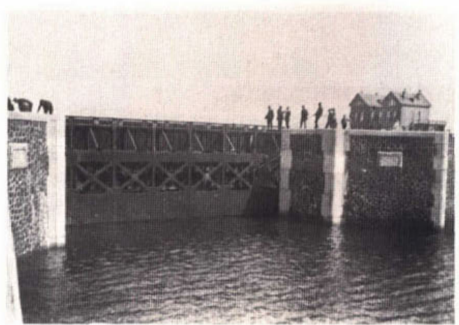
107. De grote of Oostersluis met roldeuren in het kanaal door Zuid-Beveland te Hansweerd.
