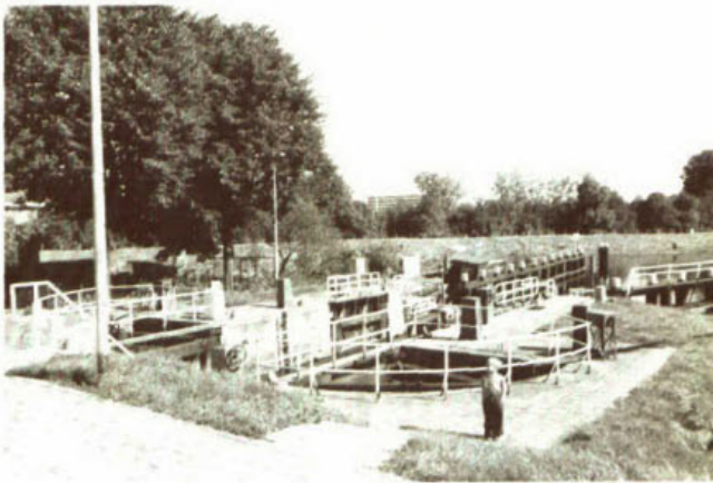
358. De Waaiersluis bij Gouda; door de waaierdeuren kan de schutsluis tevens als spuisluis worden gebruikt.
