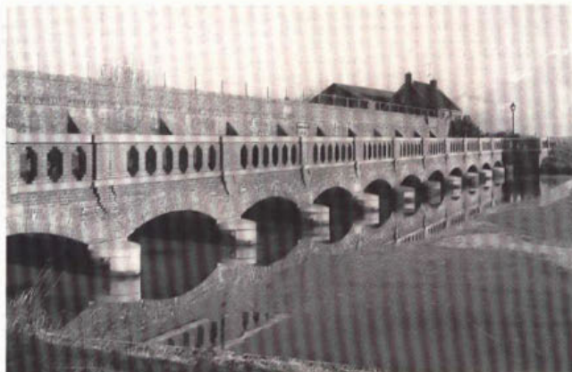
333. Uitwateringssluizen onder de Nieuwe Friese Brug bij Munnekezijl.
