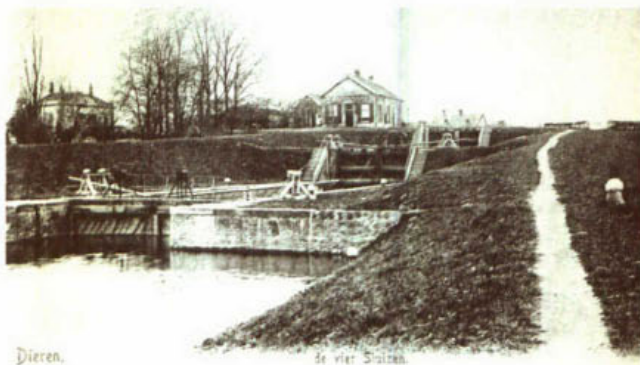
86. Drietrapsluis in het Apeldoornsch Kanaal te Dieren uit 1869.
