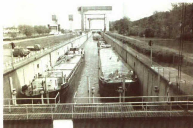
138. De Prinses Irenesluis in het Amsterdam-Rijnkanaal bij Wijk bij Duurstede, uitgevoerd als schutsluis met tussenhoofd.
