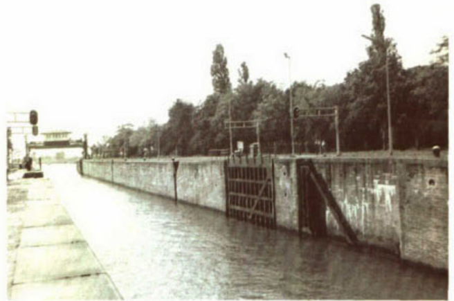
122. Keer-schutsluis in het Maas-Waalkanaal te Heumen.
