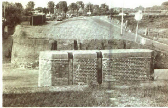
348. Coupure met twee openingen voor schotbalken in de Beusichemse Dijk bij Culemborg.
