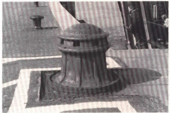
458. Draaibare 'bolder' bij de Middensluis te IJmuiden voor het naar binnen slepen van de schepen.
