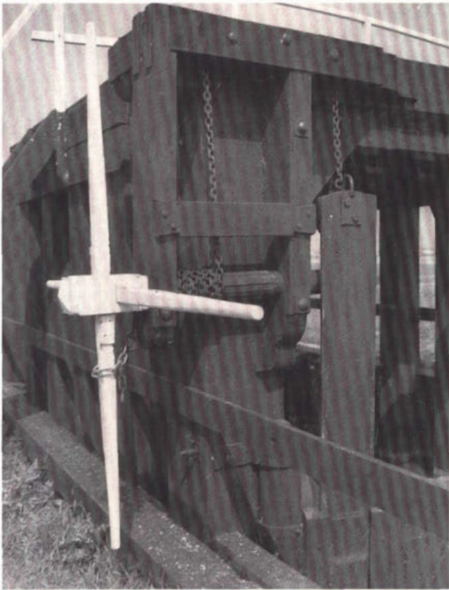
464. Rinket met windas, bevestigd tegen een slagstijl van het Bleiswijkse Verlaat bij Bleiswijk tussen de Rottemeren en de Lange Vaart.
