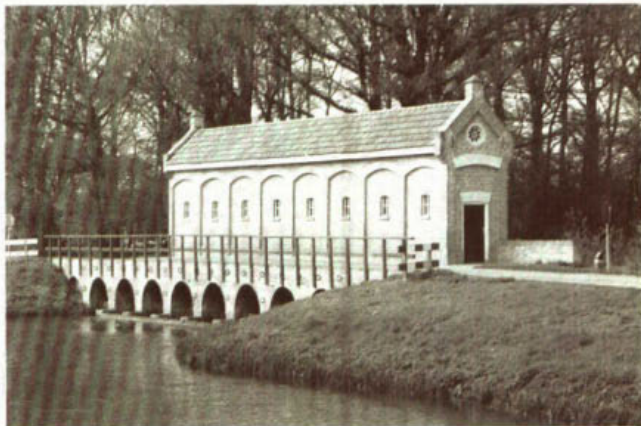
104. Ontlastsluis van het Kanaal Almelo-Nordhorn naar de Beneden-Dinkel.
