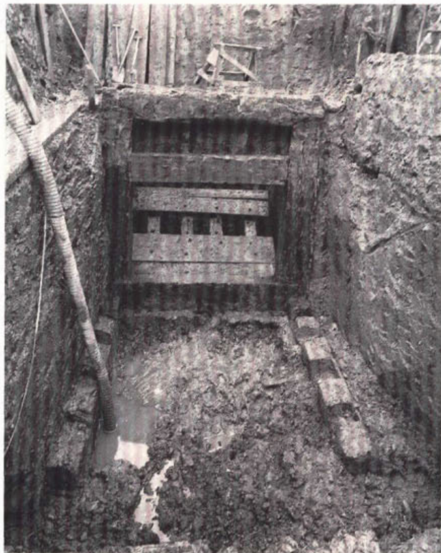
20. De klepdeur van de 13de-eeuwse duikersluis in de Nauwe Kerkstraat te Rotterdam tijdens de opgraving in 1942.
