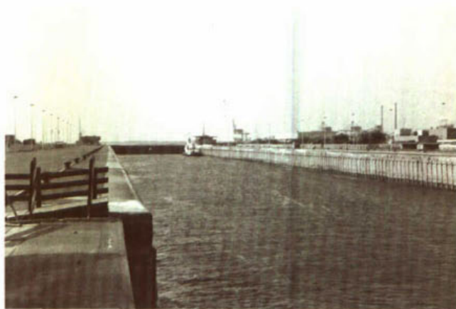
404. De Noordersluis te IJmuiden.
