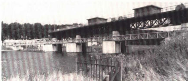
118. De stuw in de Maas bij Linne, gezien van de bovenstroomse zijde; links de scheepvaartopening, rechts de drie afvoeropeningen.
