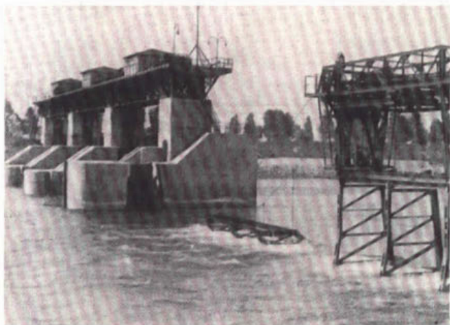
497. Het opzetten van de jukken in de scheepvaartopening van de stuw te Linne in 1925.
