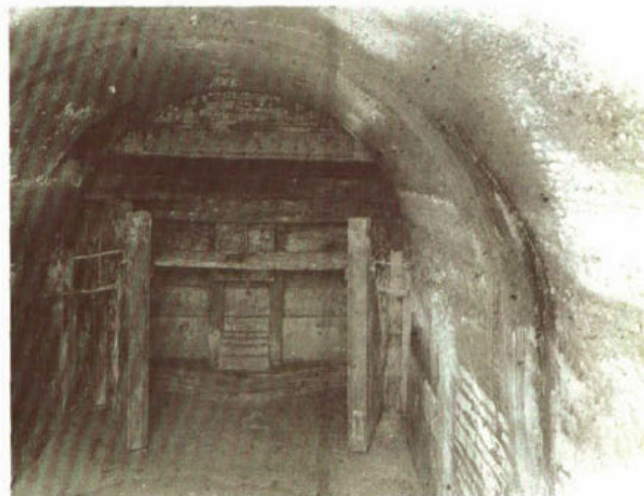
328. De Keizerinnesluis te Rotterdam; achter de puntdeuren is later een wand met schuif gebouwd.
