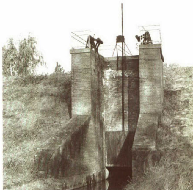
290. Schuif met heugelstang in een uitwateringssluis bij Heukelum.
