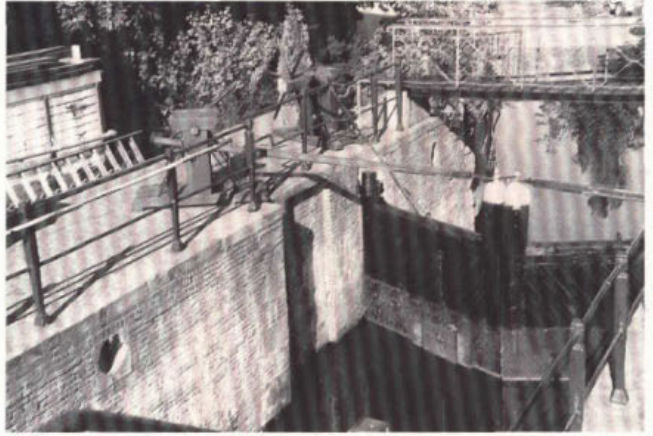
463. Rinket met kaapstanders in de schutsluis te Westzanner Overtoom.
