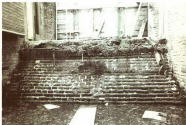
440. Stenen stortmuur in het Berkelsche Verlaat in de Zweth bij Berkel en Rodenrijs.
