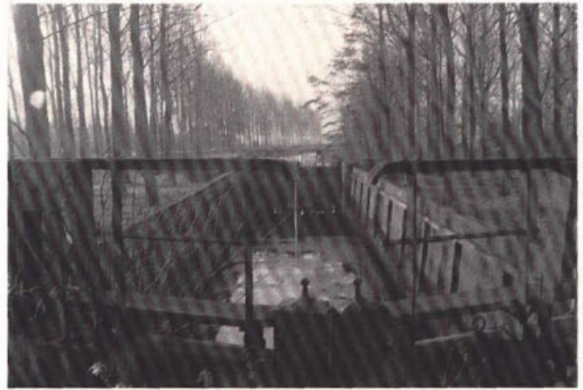
450. Hoog gefundeerde kolkwand van de schutsluis in de uitmonding van de Gracht in de Helomavaart.
