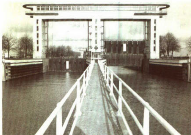
424. Tweelingsluis (Beatrixsluis) in het Lekkanaal bij Nieuwegein.
