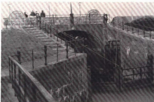
178. Bewegingsmechanisme met touwen en lieren in de schutsluis te Termunterzijl.
