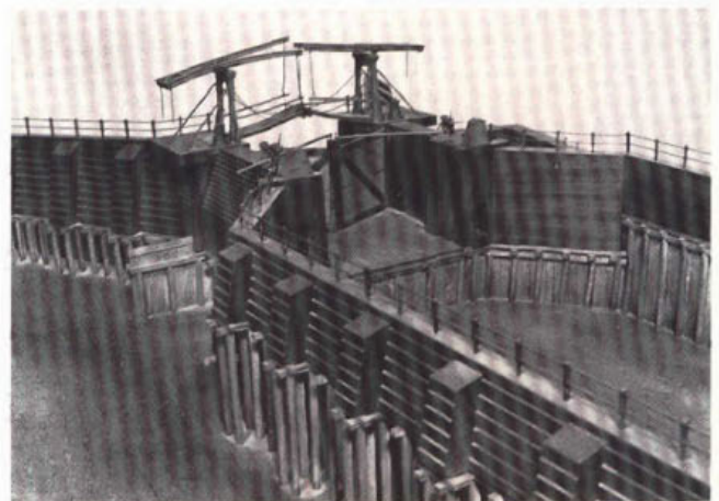
381. Maquette van de Utrechtse Gemeentesluis te Vreeswijk (Nieuwegein) met gemetselde sluiswanden, voorzien van contreforten of penanten.
