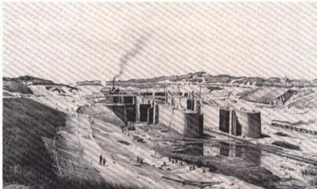
87. De eerste Noordzeesluizen te IJmuiden tijdens de bouw in 1876.
