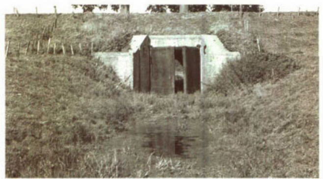
98. Ontlastsluis bij Nederhemert-Zuid; eerste sluis met een duiker van gewapend beton.
