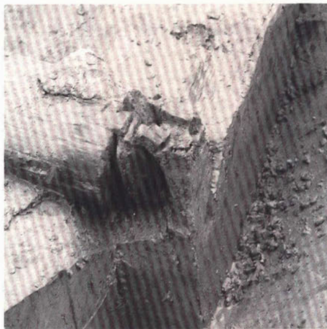
13. Duiker met scharnierbevestiging voor een klep te Schiedam-Kethel volgens C. Wind.
