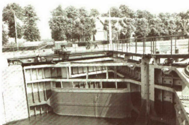
222. Waaiervlotdeur in de Wilhelminasluis bij Andel.
