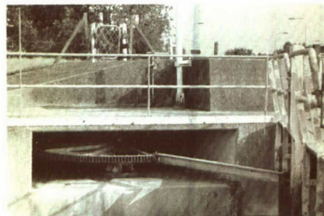
182. Het halve Panamawiel in het sluishoofd van de oude schutsluis te Delfzijl.
