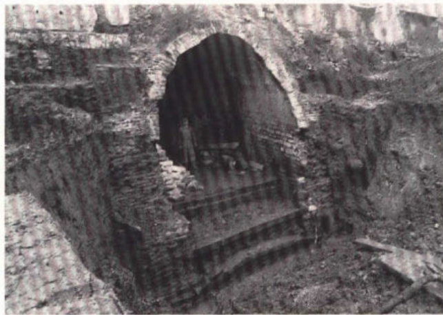
27. Kralingsche of Oostersche sluis in de Rotte te Rotterdam tijdens de opruimingswerkzaamheden in 1942.
