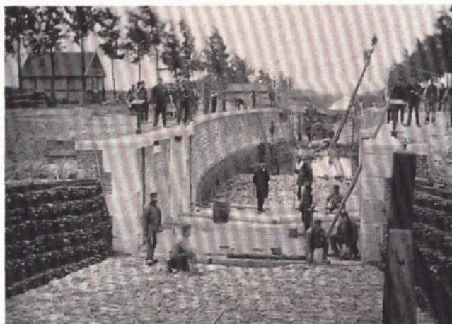
402. Schutsluis te Kuinre met waaievormige kolk.
