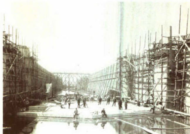
433. Aanbrengen van de vloer en de slagdrempels van de Middensluis te IJmuiden in 1894.
