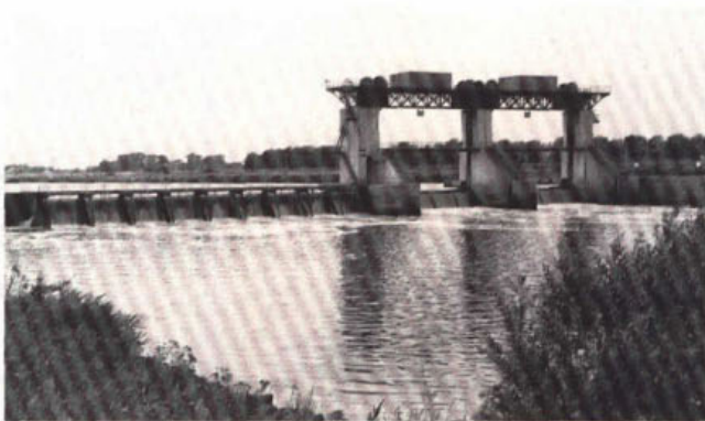
119. De stuw in de Maas bij Belfeld, gezien van de benedenstroomse zijde; links de scheepvaartopening, rechts de twee afvoeropeningen.
