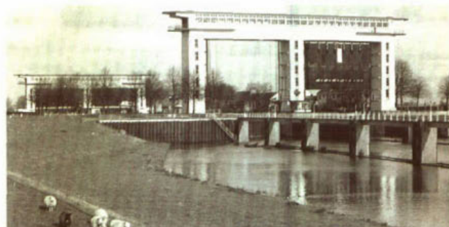
137. De Prinses Beatrixsluis in het Lekkanaal bij Vreeswijk, uitgevoerd als tweelingsluis.
