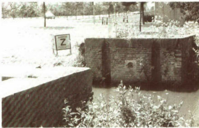
345. Schotbalkkering bij Nieuwegein.
