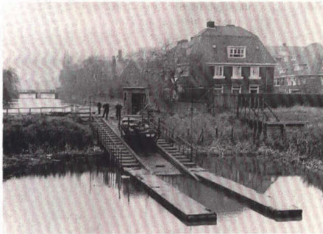
112. De geëlektrificeerde overtoom in de Boerenwetering bij de Wielingestraat te Amsterdam uit 1927.
