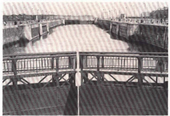
414. Het voormalige buitensluishoofd van de schutsluis in de uitmonding van de Linge in de Boven Merwede te Gorinchem.
