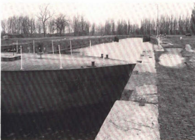
355. Het Droogdok te Hellevoetsluis met schipdeur en tussenhoofd met puntdeuren.
