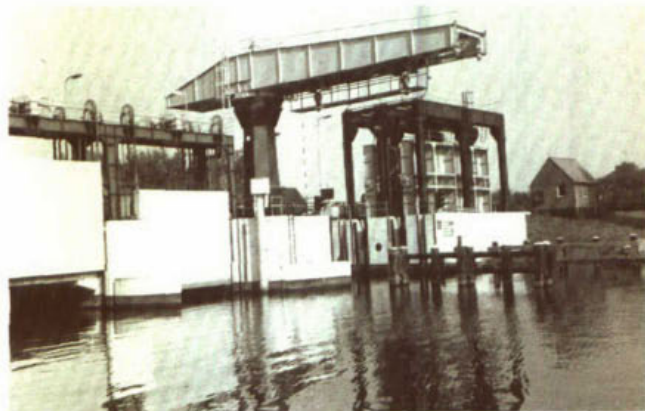
297. Hefdeur met portaal- en torenkraan in de keersluis bij Kadoelen.
