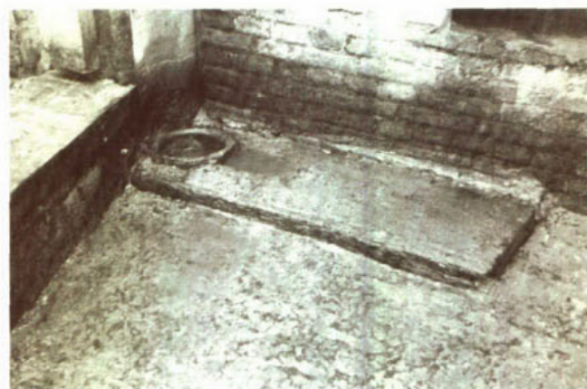
377. Houten komplaat voor een puntdeur met links de houten slagdrempel in het Berkelsche Verlaat.
