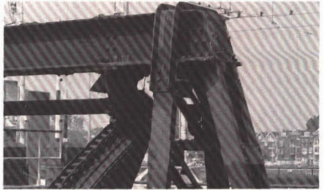
261. Bewegingsmechanisme van de segmentdeur in de Kleine Parksluis te Rotterdam.
