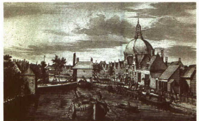
33. De schutsluis met hefdeuren te Leidschendam op een gekleurde gravure van P.F. Smith uit circa 1668.
