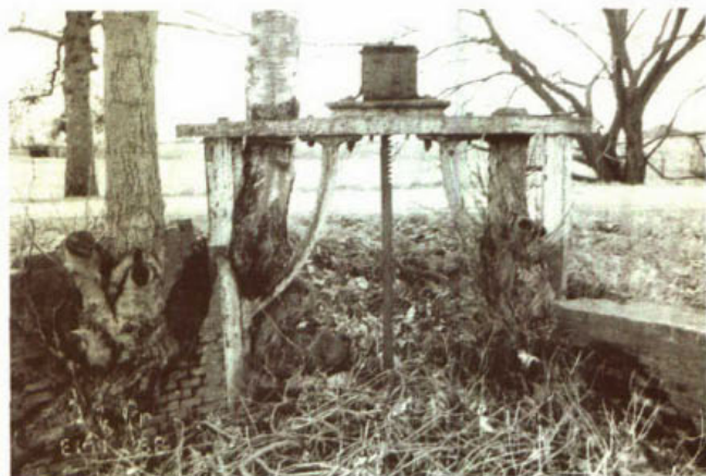
291. Gietijzeren portaal van een inlaatsluisje in de Grift langs het Apeldoornsch Kanaal.
