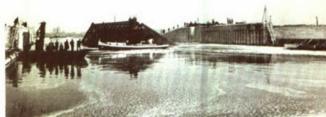
116. Aankomst van een stalen roldeur te IJmuiden.
