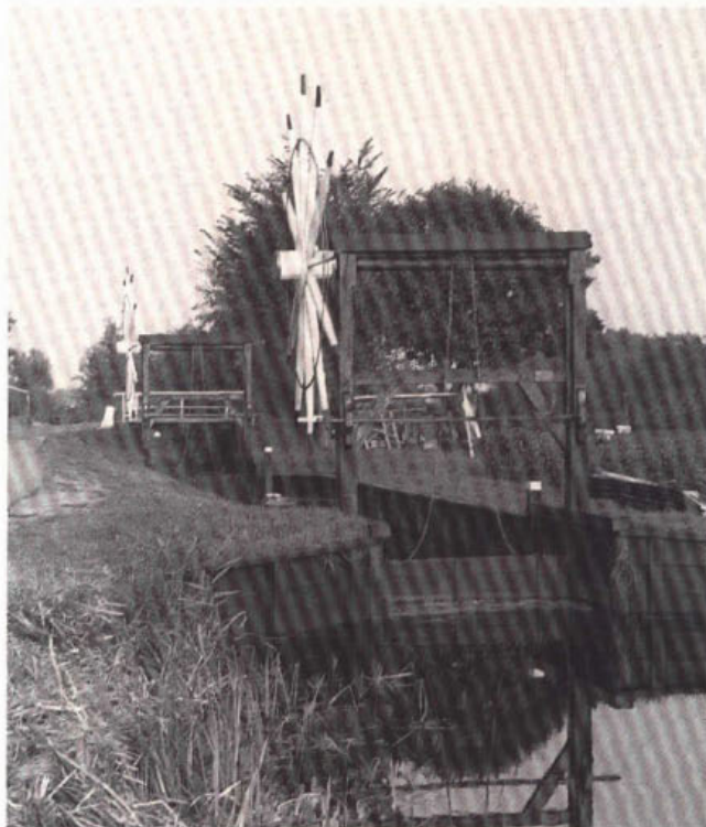
24. Schutsluis bij Tienhoven met schotdeuren.
