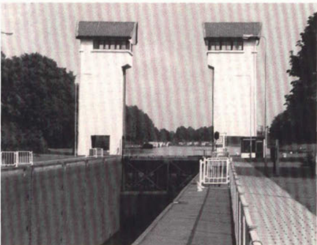
294. Sluishoofd met hefdeur in het Twenthekanaal te Hengelo.
