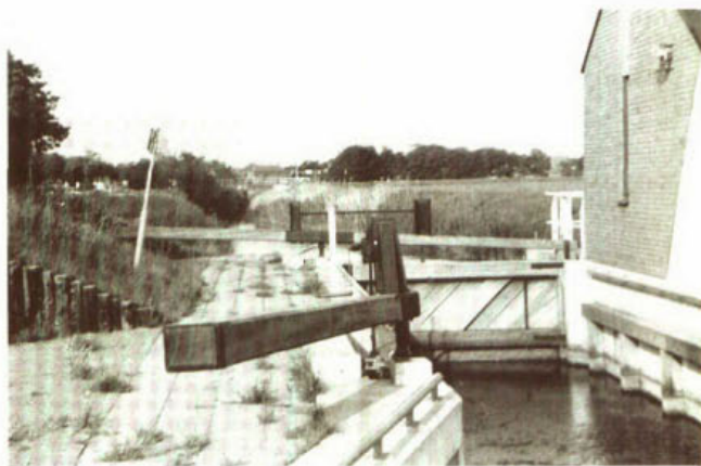
149. Houten enkele draaideur met draaiboom in schutsluis in de Loppersumer Wijmers bij Loppersum.
