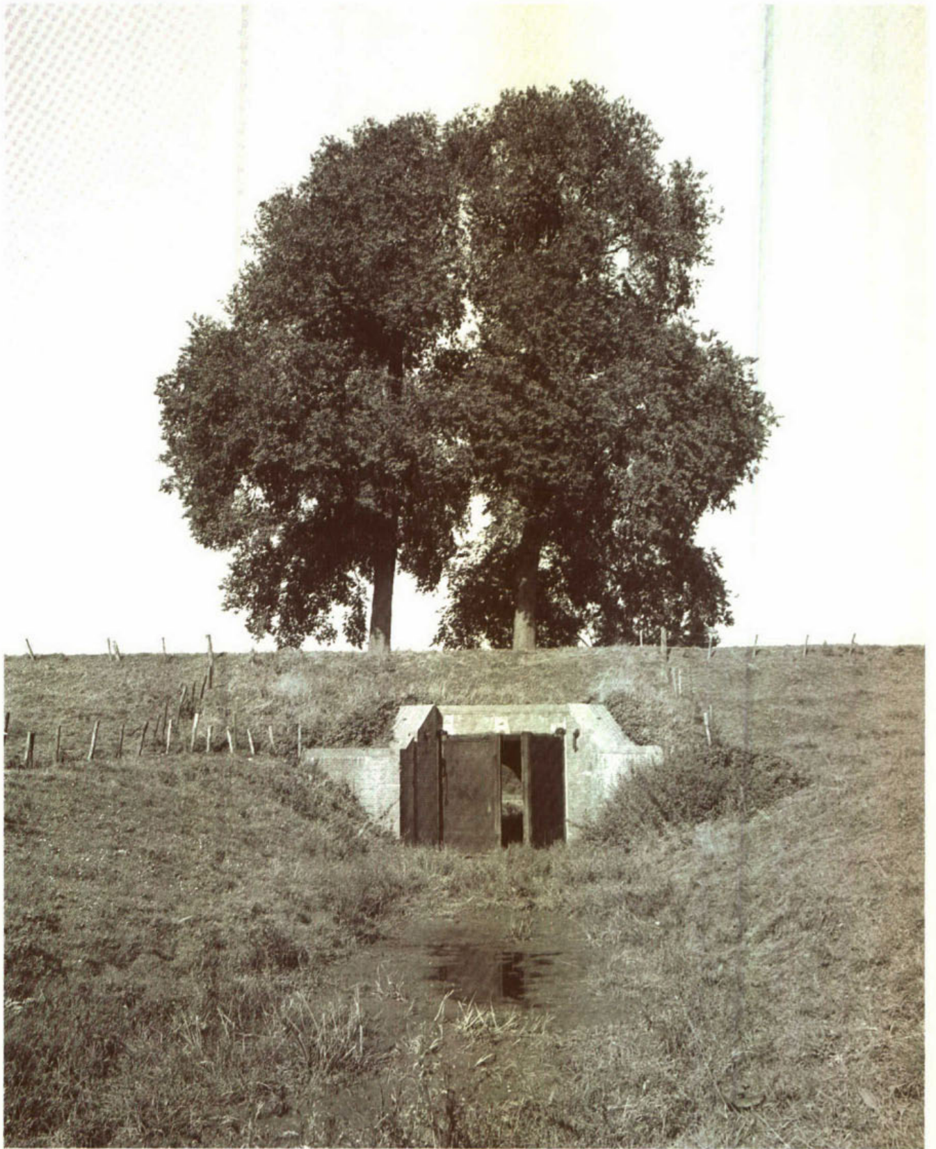
Ontlast- annex inlaatsluis in de Maasdijk bij Nederhemert-Zuid, zie pag. 48 en 145. (Fotografische Dienst Bouwkunde, TU Delft)
