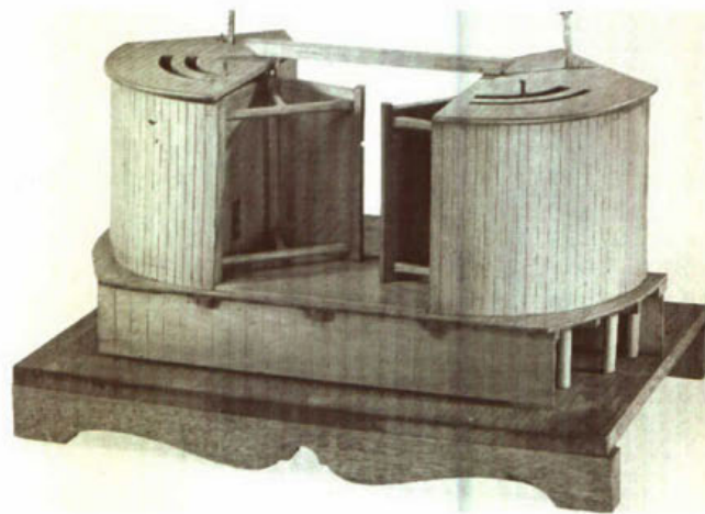
60. Maquette van de waaiersluis van Jan Blanken.
