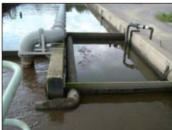
FOSFAATSTRIPPER RWZI HOLTEN
