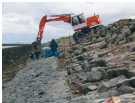
WERKZAAMHEDEN AAN DE AFSLUITDIJK (DIENSTKRING AFSLUITDIJK, DHR. C. VAN DER MADE)
