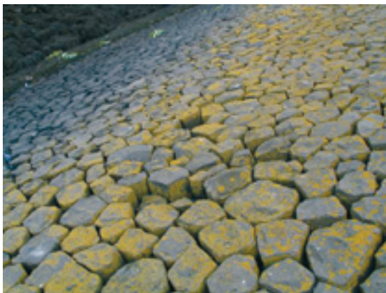
VERZAKKING IN BEKLEDING AFSLUITDIJK (DIENSTKRING AFSLUITDIJK, DHR. C. VAN DER MADE)
