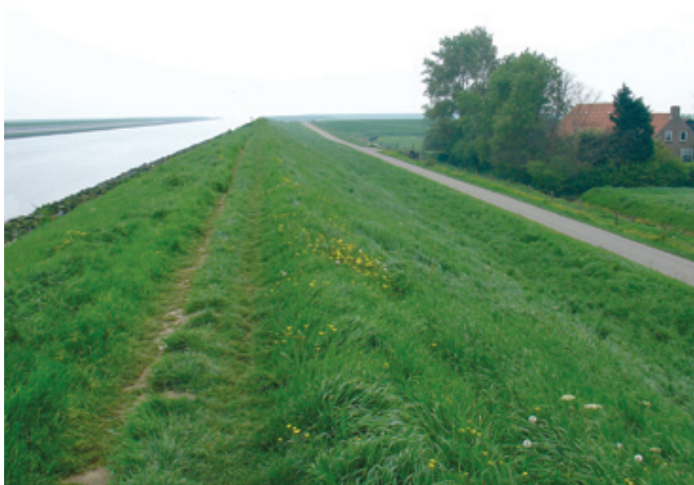
DIJK MET GRASBEKLEDING EN WIELSPOREN (BAKKENIST &amp; ZOMER)
