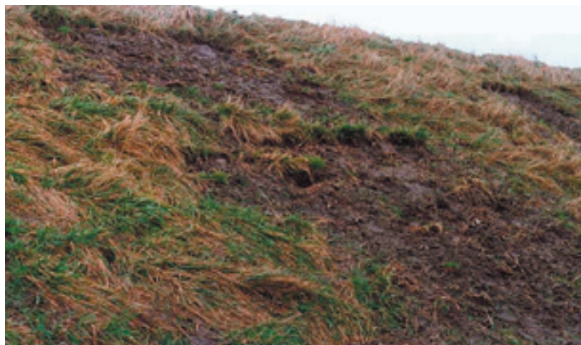
EROSIE BUITENTALUD (RWS/DWV)
