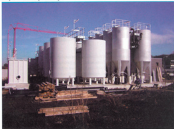
Zandfilter in aanbouw bij rwzi Steenwijk.
