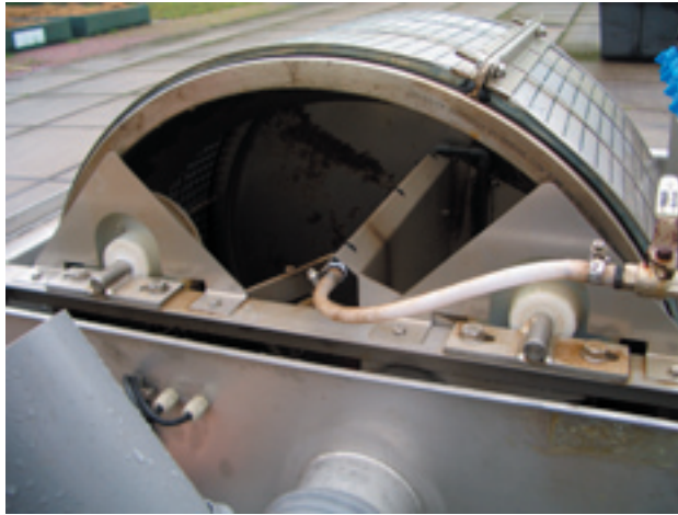
AFBEELDING 32 VERWIJDERING VAN ZWEVENDE STOF IN TROMMELZEEF
