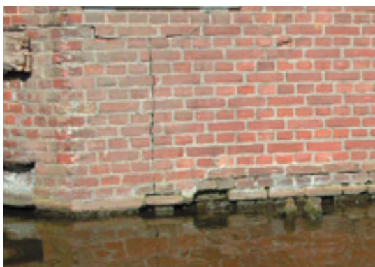
AFBEELDING 12 ENKELE VOORBEELDEN VAN SCHEURVORMING
