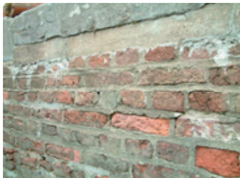
AFBEELDING 10 MOGELIJK SCHADEBEELD BIJ EEN VERKEERDE REPARATIE
