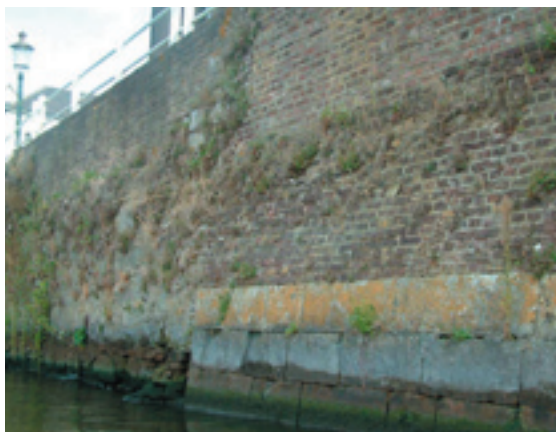
AFBEELDING 11 BIJ DEZE CONSTRUCTIE KAN (OA.) WORTELGROEI VOOR PROBLEMEN ZORGEN
