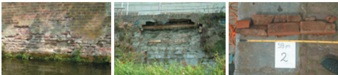
AFBEELDING 9 MOGELIJKE SCHADEBEELDEN BIJ GEMETSELDE CONSTRUCTIES
