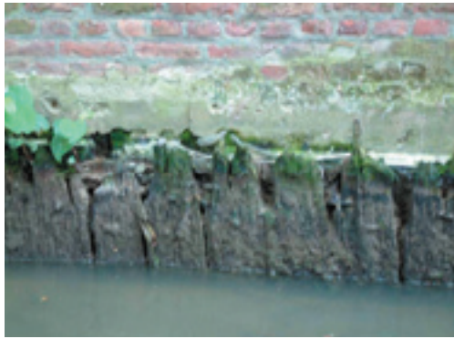
AFBEELDING 14 EEN VOORBEELD VAN HOUTAANTASTING AAN DE BOVENZIJDJE VAN EEN DAMPLANK
