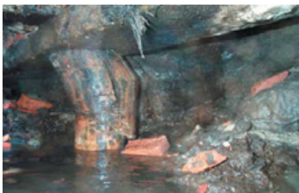
AFBEELDING 15 DE BEKENDE RISICOVOLLE GEBIEDEN BACTERIËLE AANTASTING PAALFUNDERING (AFBEELDING VAN STICHTING HOUT RESEARCH (SHR)) EN AANGETASTE EN GEKNAKTE PAAL (FOTO VAN FUGRO INGENIEURSBUREAU BV)
