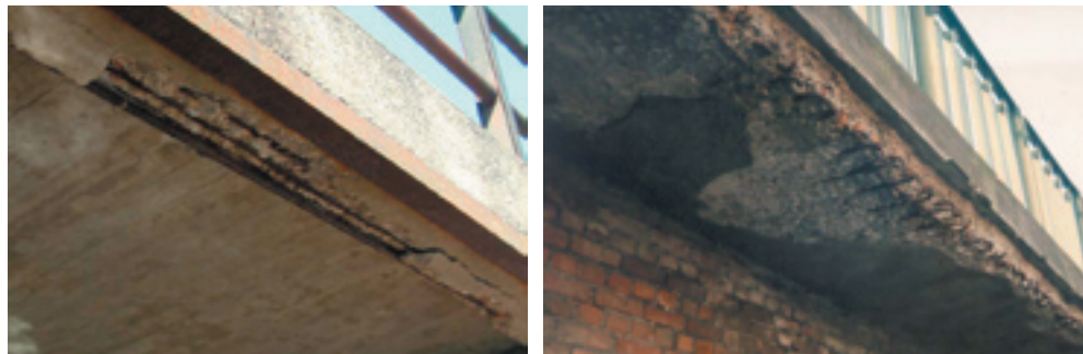
AFBEELDING 13 ENKELE VOORBEELDEN VAN BETONSCHADE
