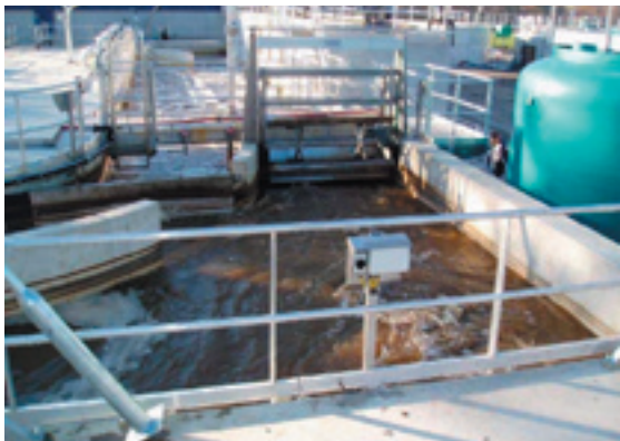
AFBEELDING 13 DE DRIJFLAAGAFVOER IN HET OMLOOPSYSTEEM
