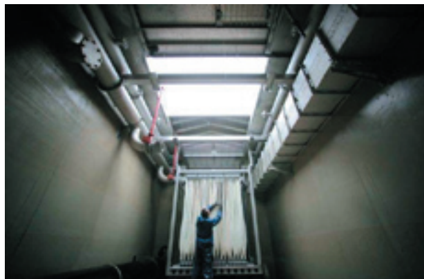
AFBEELDING 14 SCHEMA VAN EEN MEMBRAANCASSETTE (LINKS) EN EEN FOTO VAN EEN CASSETTE IN EEN MEMBRAANTANK (RECHTS)
