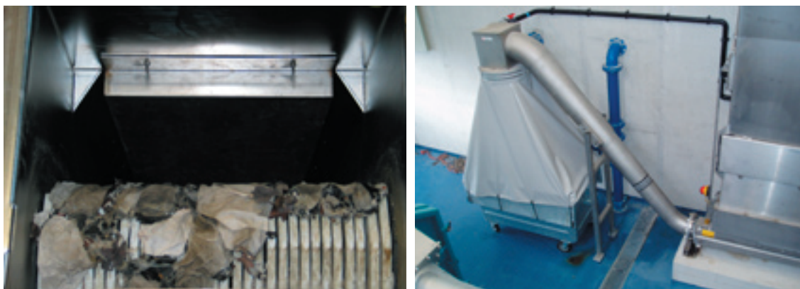
AFBEELDING 7 FOTO'S VAN DE FIJNROOSTERS EN DE ROOSTERGOEDCONTAINER
