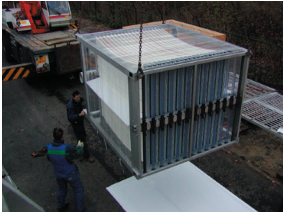
AFBEELDING 5 EÉN MEMBRAANPAKKET MET AAN ONDERZIJDE BELUCHTINGSBUIZEN (BLAUW)
