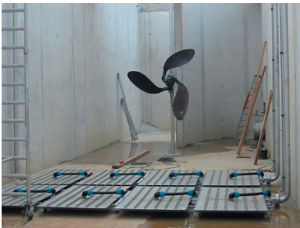
AFBEELDING 3 VOORSTUWER EN ENKELE BELUCHTINGSELEMENTEN MBR VARSSEVELD
