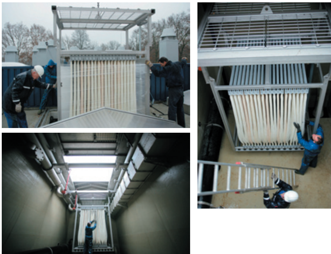
AFBEELDING 6 DE INSTALLATIE VAN DE MEMBRAANCASSETTES
