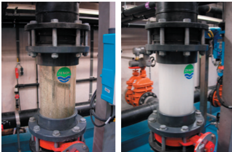
AFBEELDING 22 LUCHT IN DE PERMEAATLEIDING TIJDENS PERMEAATONTREKKING NA PARAAATMODE
