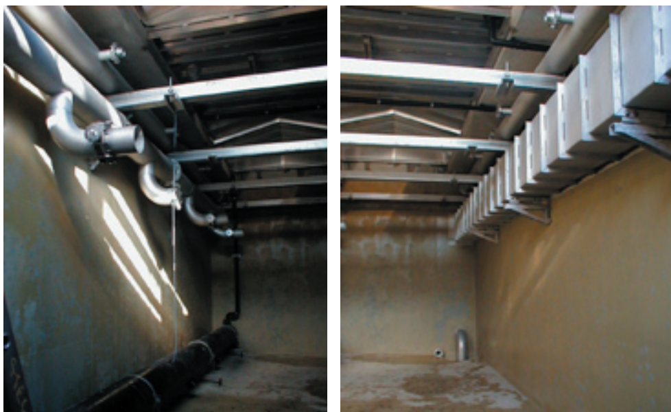
AFBEELDING 23 DE TOEVOERLEIDING (LINKS ONDER) EN AFVOERGROOT (RECHTS BOVEN) VAN DE MEMBRAANTANK
