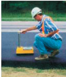
FIGUUR B5.1 NUCLEAIRE DICHTHEIDSMETER OP EEN ASFALTVERHARING
