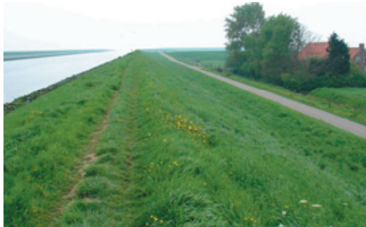
AANZICHT PROFIEL DIJK MET GRASBEKLEDING
