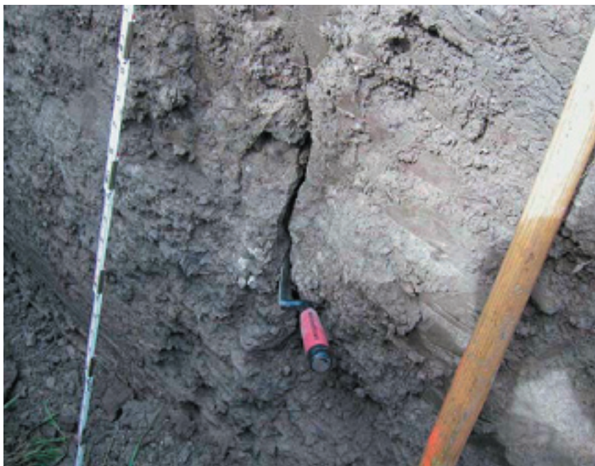
FIGUUR 5.34 ONDERGRONDSE SCHEUREN IN RIO GRANDE DIJK
