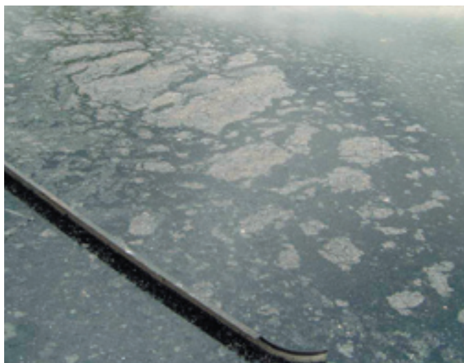
AFBEELDING 31 DRIJFLAAG OP DE VOORBEZINKTANK TIJDENS PE-DOSERING
