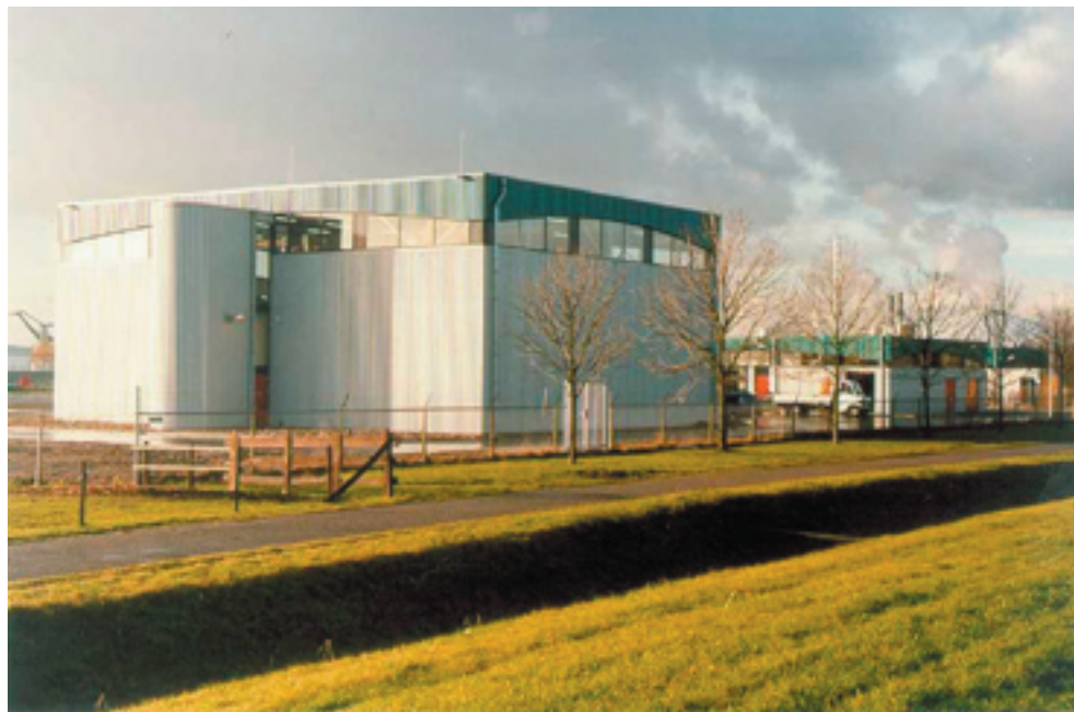
FILTERGEBOUW RWZI DE GROOTE LUCHT
